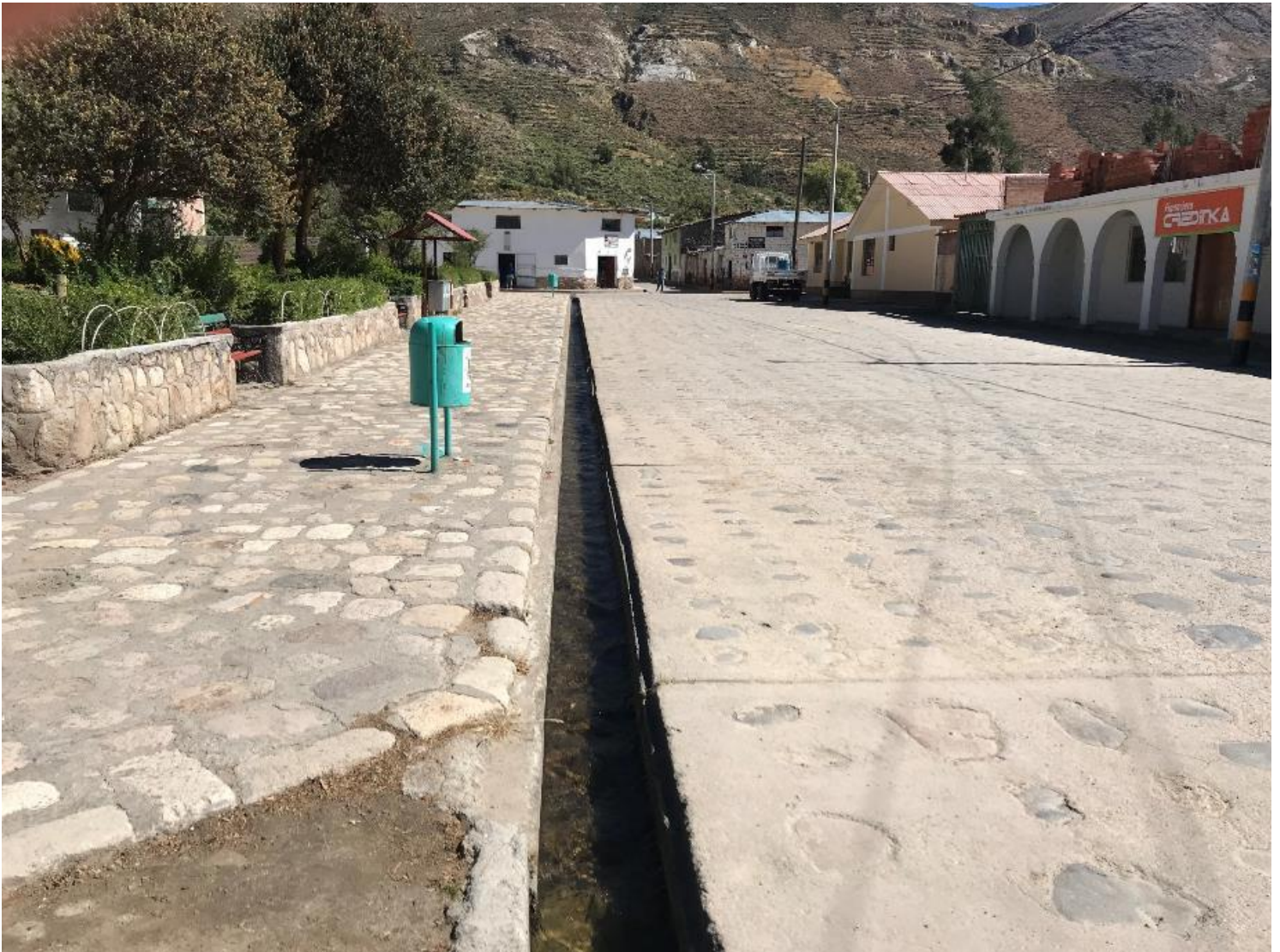
Fig. 32 Canal abierto de concreto en Plaza de Aucará que lleva agua desde la zona alta, hacia la zona agrícola ubicada en la zona más baja (Fuente propia, 2019)
