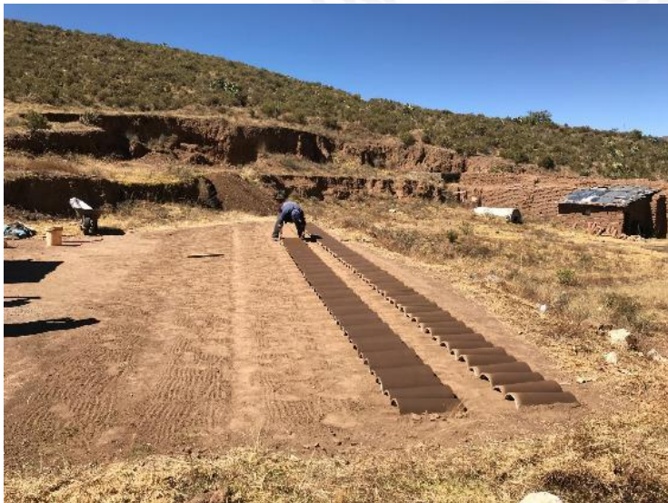
Fig. 50 Secado previo a la cocción de las tejas que usa como cantera de tierra un espacio cercano al centro de Aucará (Fuente propia 2019)
