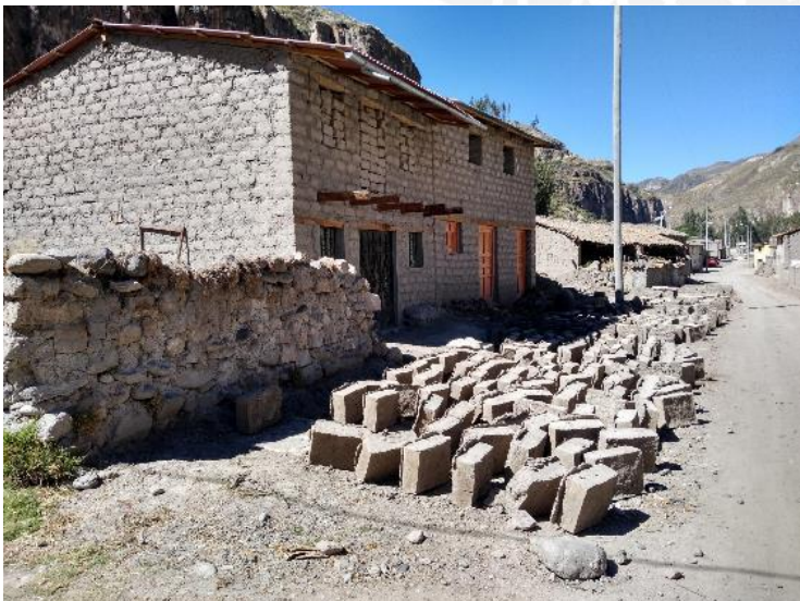
Fig. 51 Secado de bloques de adobe para construcción (Fuente propia 2019)
