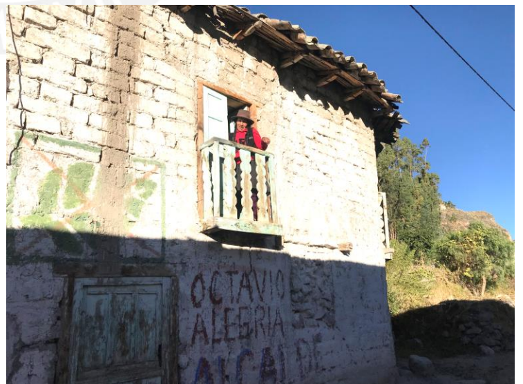
Fig. 48 Señora parada en el balcón de segundo piso de su vivienda frente a calle de Sondondo (Fuente propia 2019)
