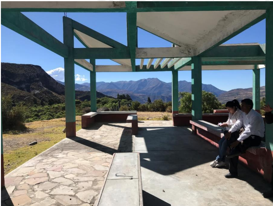
Fig. 17 Mirador de Tranca Pata de Aucará, construcción reciente en concreto de MINCETUR que no tiene relación con el contexto (Fuente propia, 2019)
