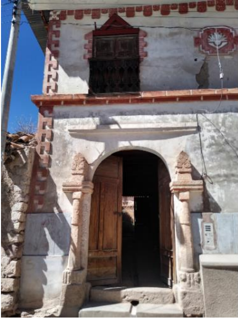
1. INGRESO LATERAL A VIVIENDA Se observa canal de salida de agua
