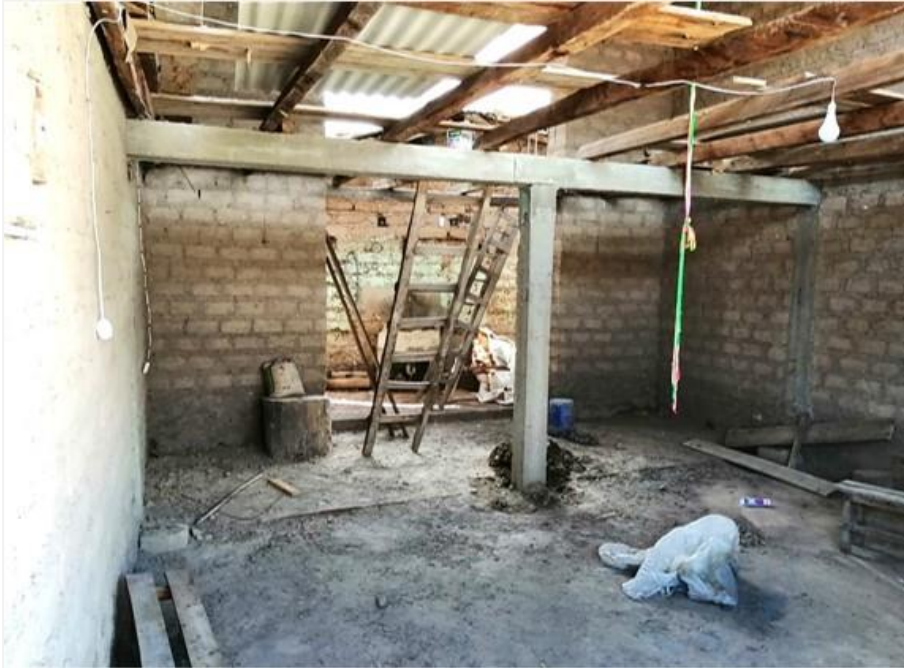
Fig. 16 Vista interior de la construcción de una vivienda en Aucará con adobe (material de construcción local) y estructura de columnas y vigas de concreto, sobre las cuales se colocan vigas de madera para el techo (Fuente propia, 2019)
