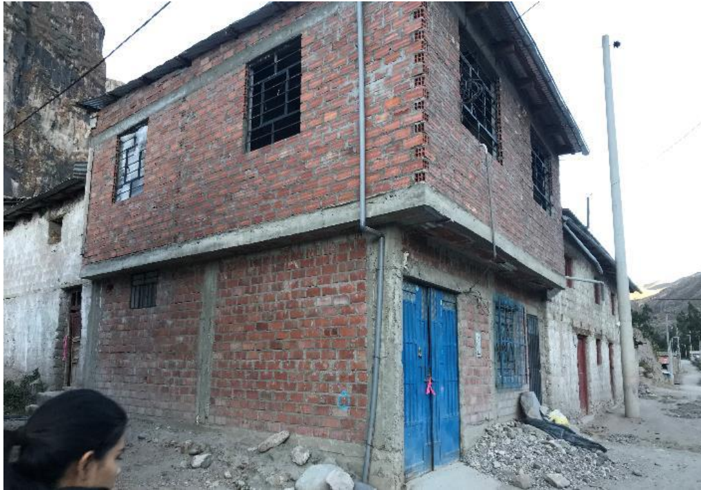
Fig. 61 Vivienda de 2 niveles en ladrillo y concreto en Sondono con carpintería metálica en la fachada, con mayor altura con dos viviendas con adobe de menor altura al lado (Fuente propia, 2019)
