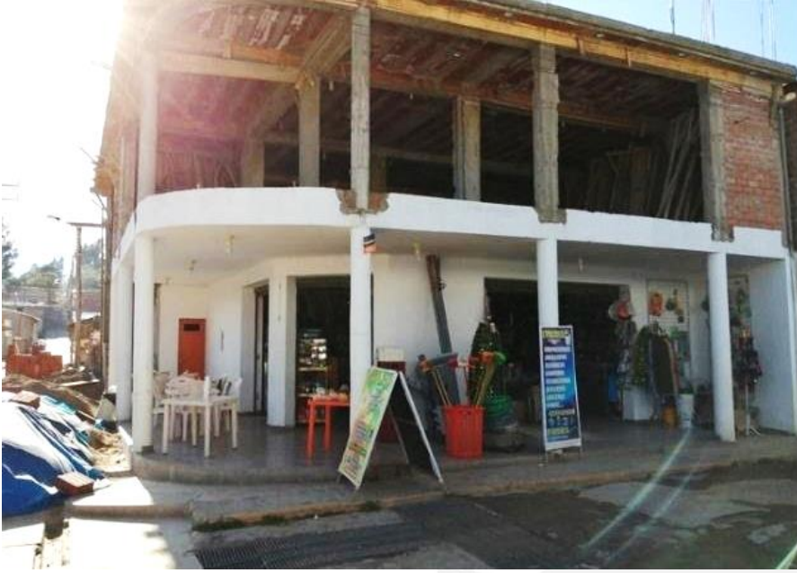
Fig. 3 Local comercial restaurante – bodega en ampliación frente a la plaza principal de Cabana, Ayacucho. Local comercial en construcción de 2 niveles, ubicado en esquina frente, construido con columnas pilotis de concreto y albañilería de ladrillo, las aperturas de vanos no consideran el contexto en el que se encuentra (Fuente propia, 2019)
