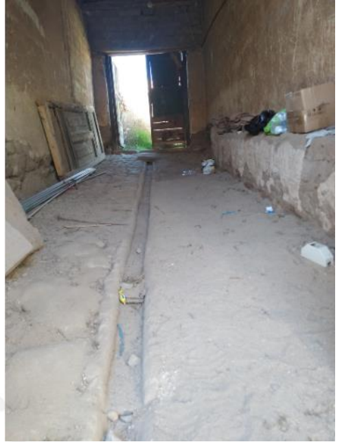
3. VISTA DEL ZAGUAN Con vista del corredor con el canal que viene del huerto interno
