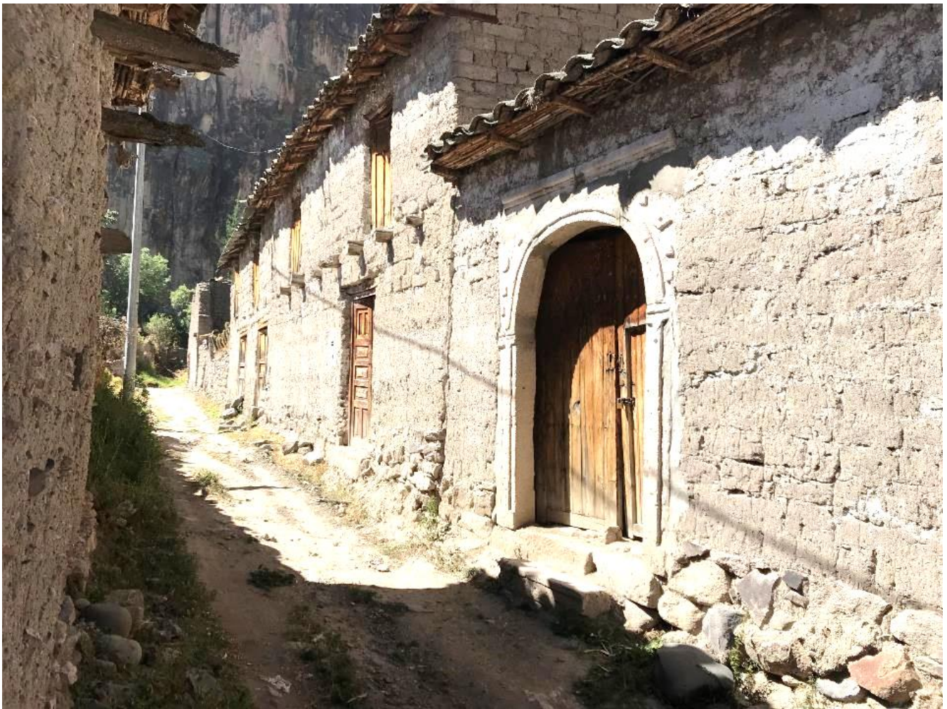
Fig. 2 Vivienda de 2 pisos con adobe como material predominante que conserva las lógicas de construcción en el Valle de Sondondo en el centro poblado de Sondondo, Ayacucho. Lado izquierdo: evidencia de troncos de madera de antiguo balcón, tres puertas de madera con desnivel de escalones de piedra en relación con la calle y cuatro ventanas de madera que evidencian usos distintos en primer y segundo nivel. Techo de teja de arcilla y uso de material de adobe para muros de los dos niveles con sobrecimiento de piedra. Lado derecho: se observa ingreso a huerto, con arco de piedra en la entrada, puerta de madera más ancha que de las de vivienda para ingreso de la carreta con productos del campo o ganado, puerta de ingreso secundaria en una de las hojas de madera, sobrecimiento de piedra, muro de adobe y teja de arcilla en techo para proteger muro. (Fuente propia 2019)
