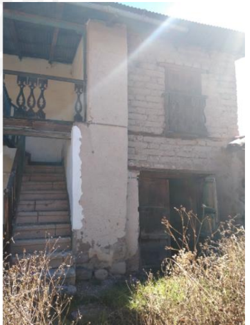
6. VISTA HUERTO A VIVIENDA Base de piedra a la altura del drenaje
