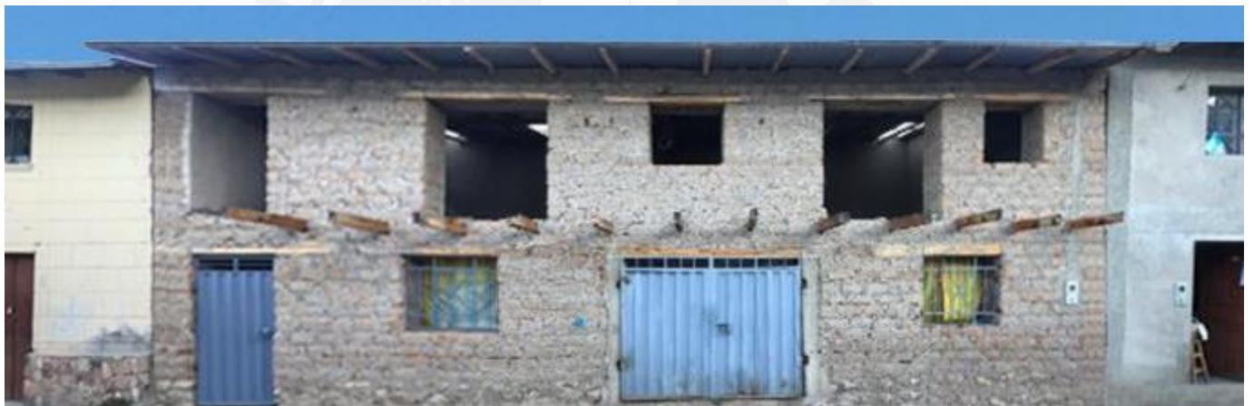
Fig. 62 Vivienda en Aucará en Adobe con grandes vanos, vigas de concreto, carpintería metálica y cubierta de calamina (Fuente propia, 2019)
