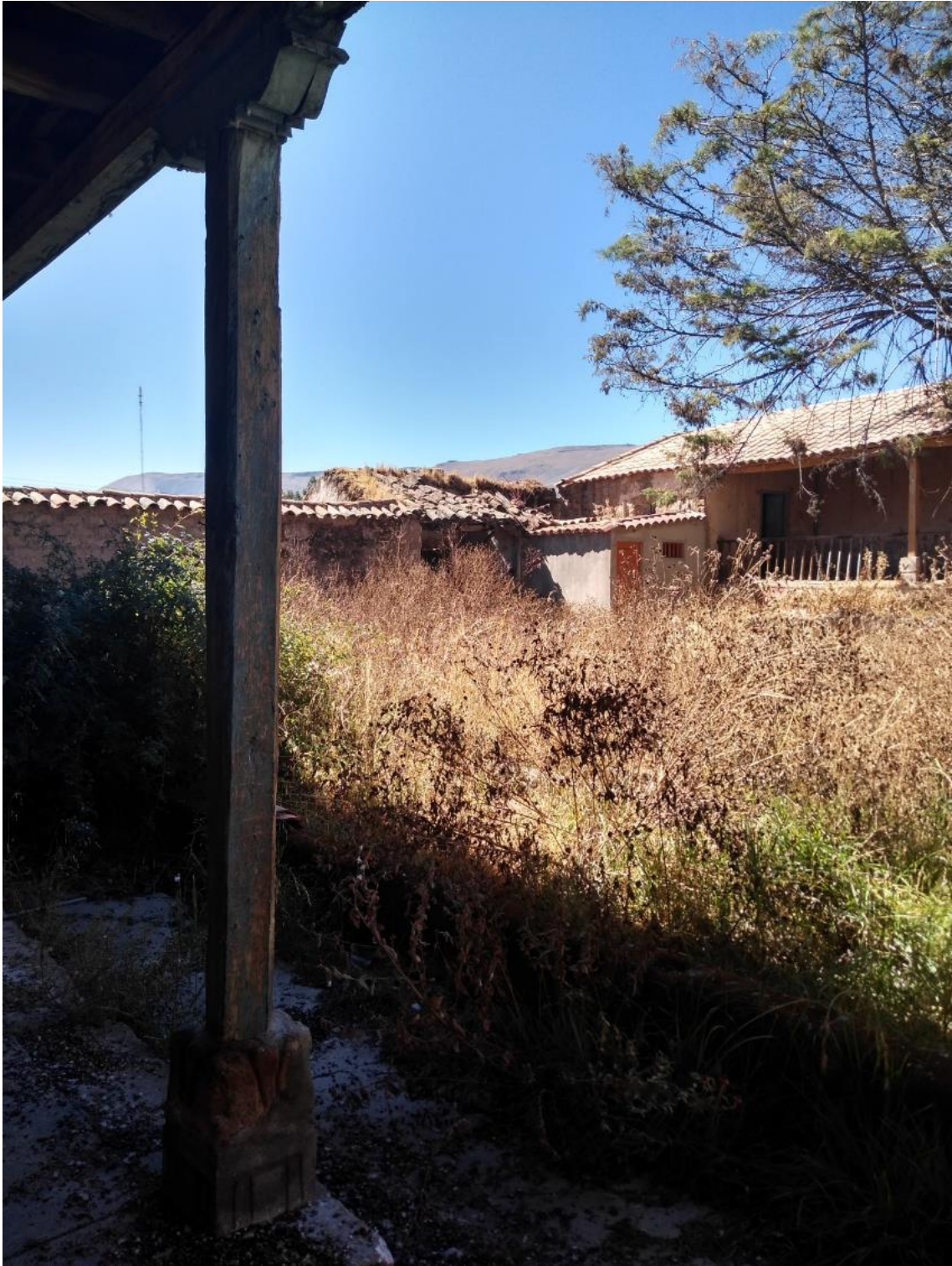
Fig. 18 Vista al huerto interior de una vivienda en Cabana desde una zona techada de tipo galería abierta, en frente se observa la vivienda de dos niveles y el cerco perimétrico (Fuente propia, 2019)
