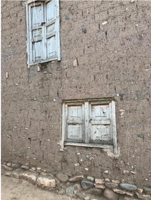
Fig. 52 Base: Piedra / Muro: Adobe / Ventana: Madera (Fuente propia 2019)
