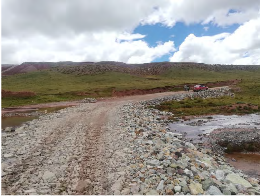
Imagen 3: Vista 1 de la Carretera Canta Huayllay km 48
