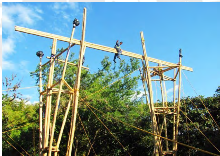
Figura 5. Armado de techos y muros de bambú.
