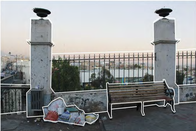
FALTA DE MANTENIMIENTO MOBILIARIO SIN CONEXIÓN VISUAL AL RÍO
