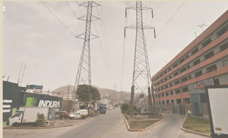
Torres de alta tensión en Lima Metropolitana
