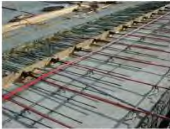
(a) Tira de retardo después del vaciar concreto en un lado
