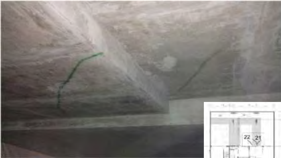
Figura 5.34: Fisuras 21 y 22
