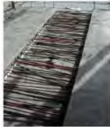
(b) Tira de retardo después de vaciar concreto en ambos lados
