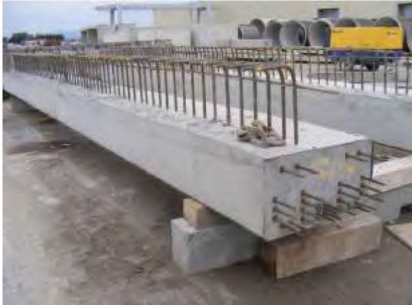
Figura 2.4: Viga Pretensada (fuente: El Hormigón, Blogger)
