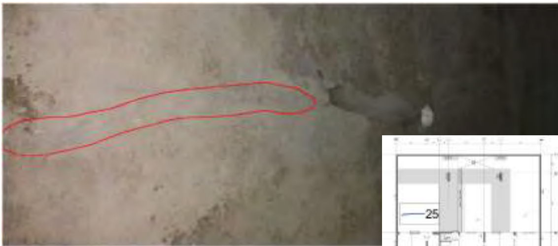
Figura 5.41: Fisura 25
