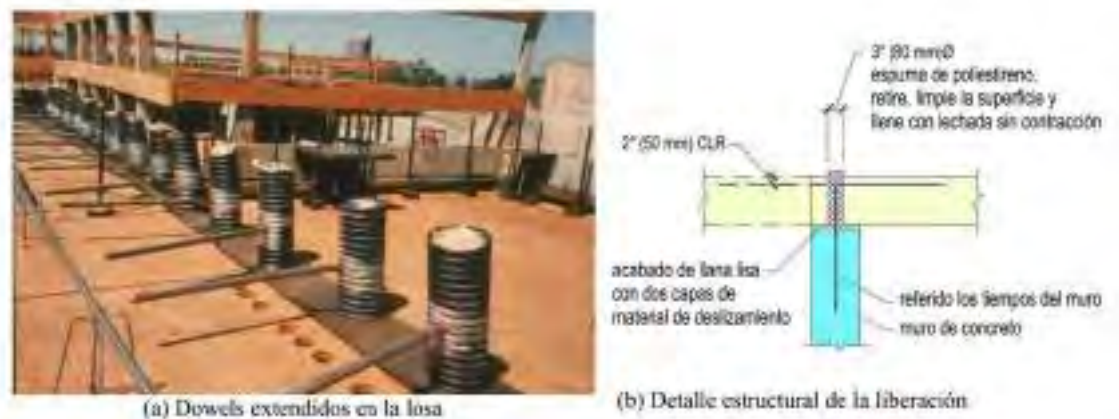
Figura 3.18 Conexiones temporalmente liberadas (Fuente: ADAPT 2016)
