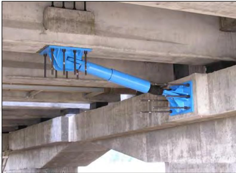
Figura 21. Disipador de fluido viscoso instalado entre la viga cabezal del pilar y viga principal del tablero de un puente, tomado de: <http://www.elemka.gr>
