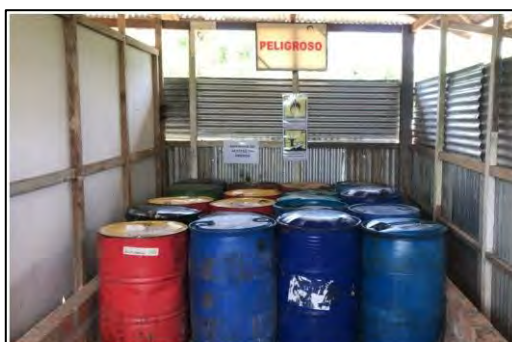
Foto N° 2: Residuos líquidos de aceites en desuso; producto del cambio de aceites para motores y aceites comestibles, dentro del muro de contención en casos de fugas, presenta etiquetado según sus características de peligrosidad: daño para el ambiente y combustible.
