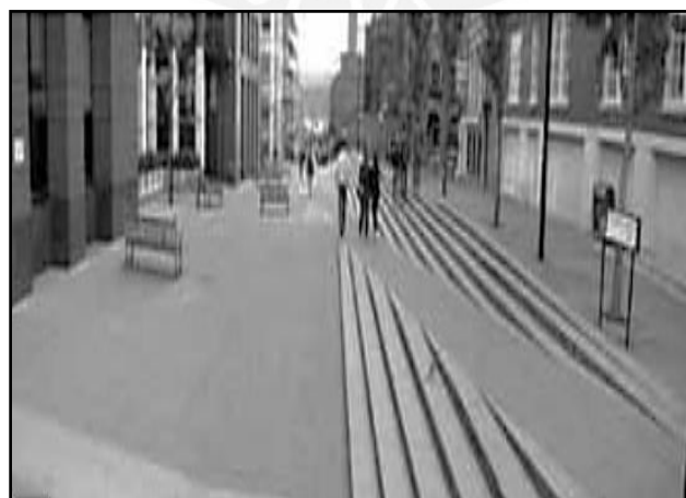
Figura 2.12. Rampa incorporada a escalera, Londres
