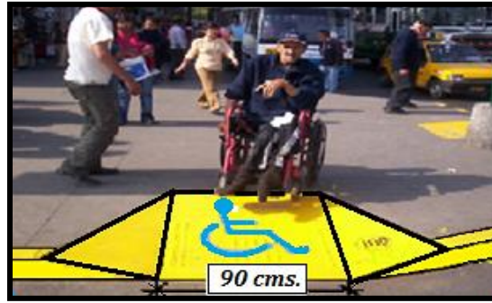
Figura 2.18. Rampa con 3 pendientes
