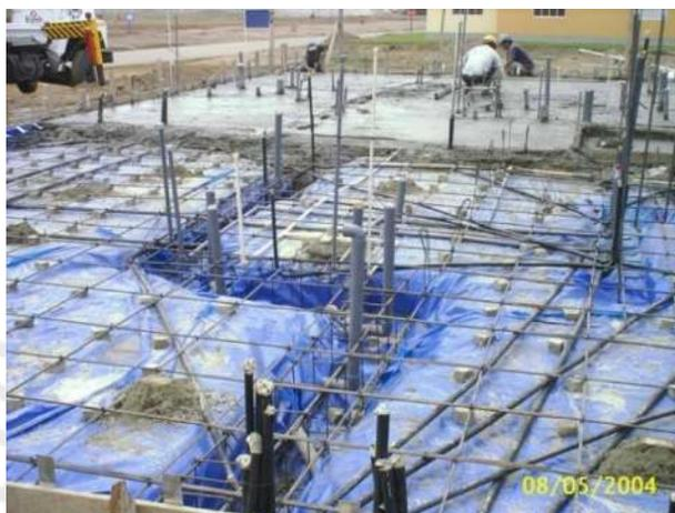
Figura 4.3. Impermeabilización de losa de cimentación de un proyecto ubicado en las Islas de San Pedro. Fuente: Ingeniero Alejandro Bondi.
