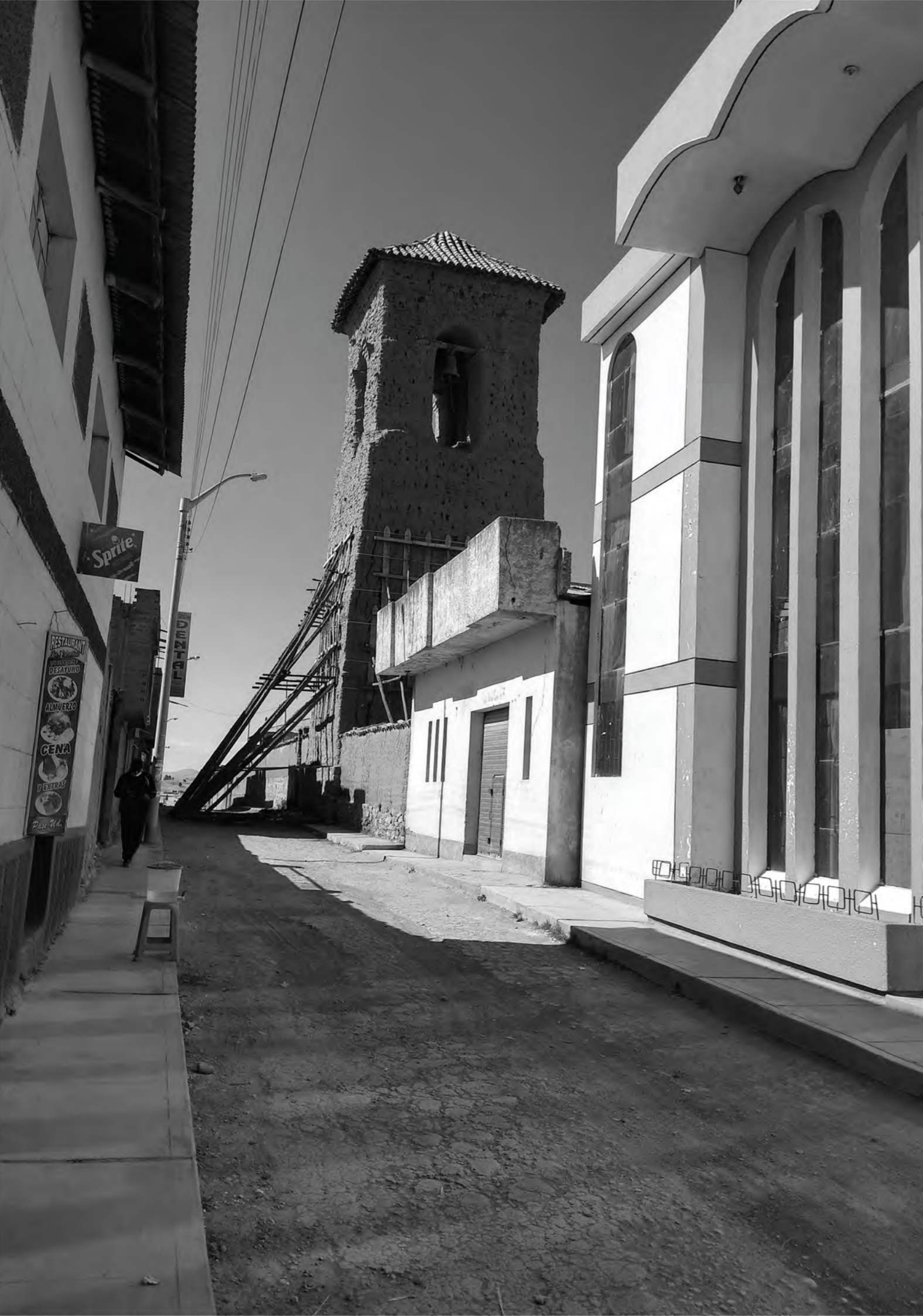
Foto: Torre del campanario apuntalado detrás del edificio de la Municipalidad. Elaboración propia.
