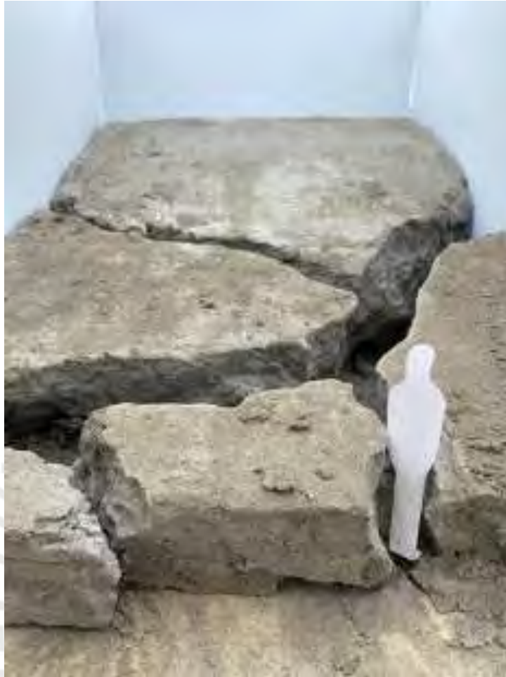
Figura 16. Navegar . Concreto agrietado, 3.5 x 5 x 2 m, 2021
