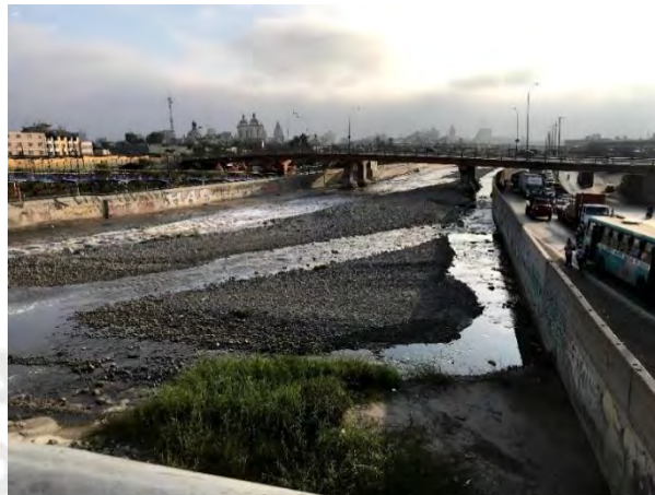
Figura 26: Paisaje del río Rímac desde el puente Balta lado derecho.
