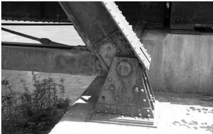
Figura 3.6: Articulación en Puente Arco de Acero (<http://bridgehunter.com>)
