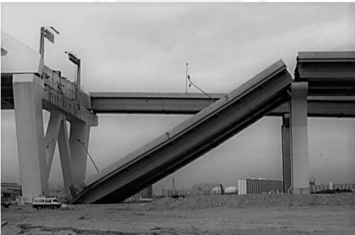
Figura 2.1: Colapso de un tramo del puente Nishihomiya en Japón durante el terremoto de Kobe de 1995 [3].
