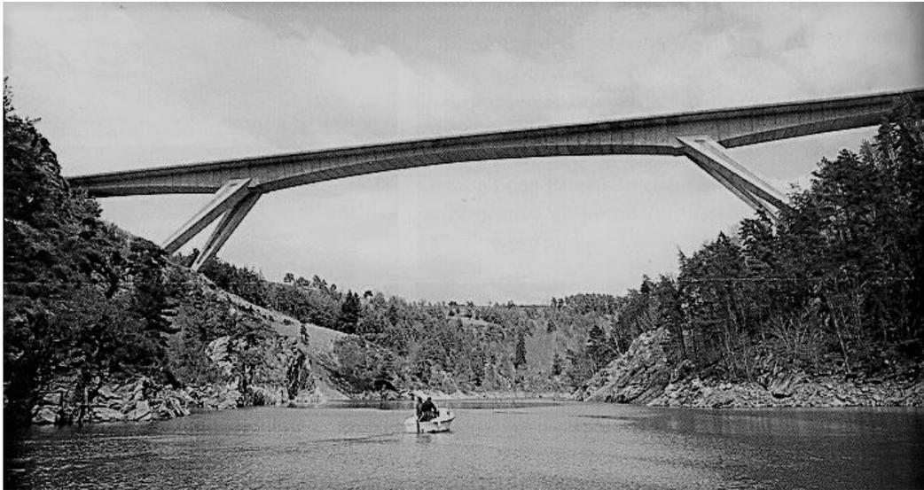
**Figura 3.11: Puente tipo pórtico.**
