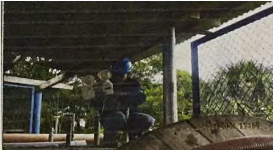
Figura 44. Inspección de equipos de emergencia
