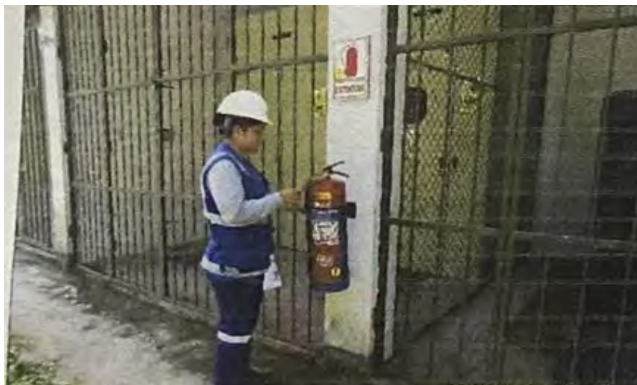
Figura 43. Inspección de Extintores
