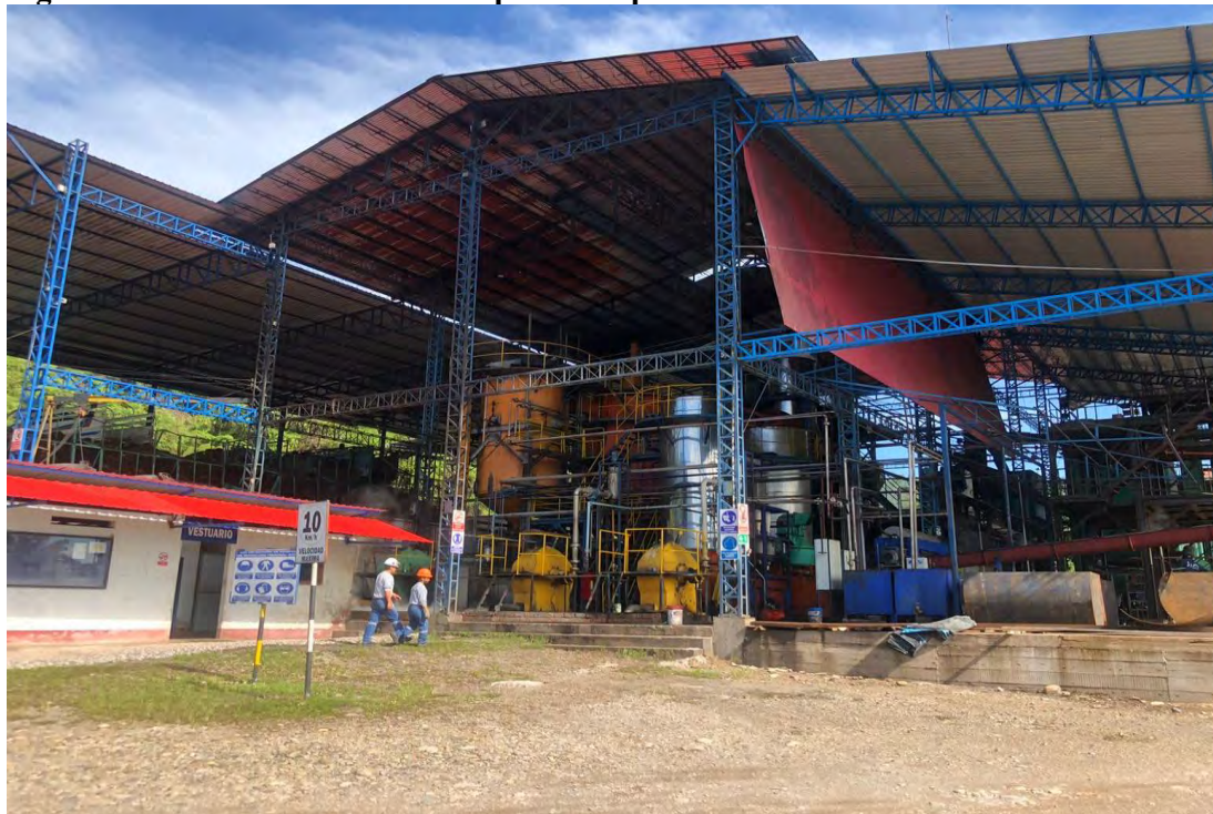
Figura Z4: Área de vestuario de la planta de producción
