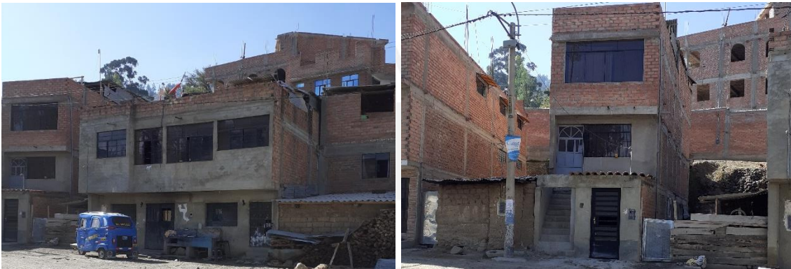
Figura 6.6. Ejemplo de vivienda de ladrillo de dos y tres pisos
