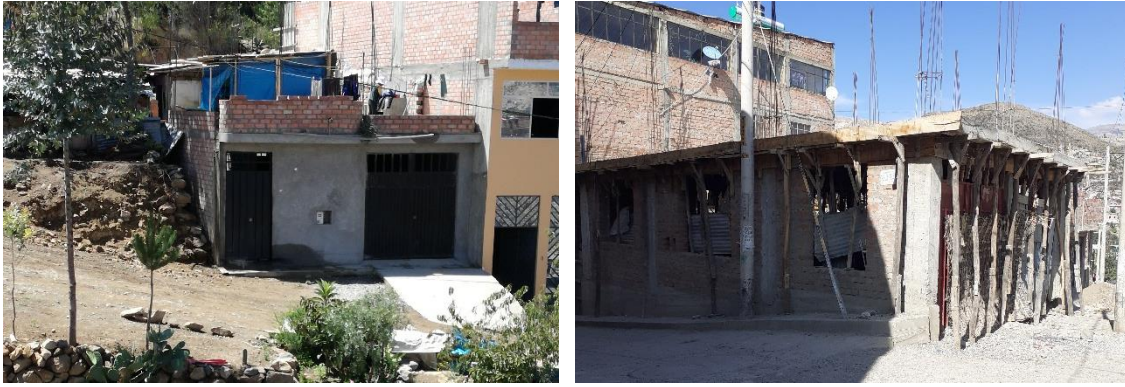
Figura 6.5. Ejemplo de vivienda de ladrillo de un piso
