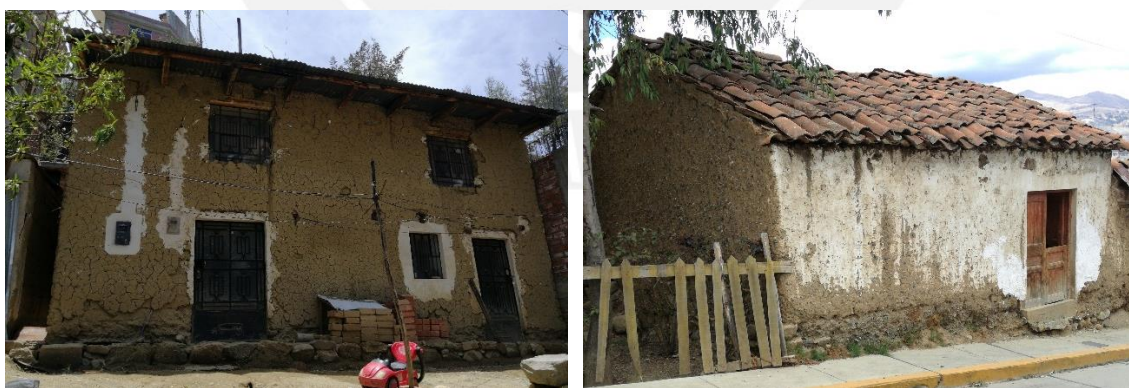
Figura 6.4. Ejemplos de vivienda de adobe de dos y un piso
