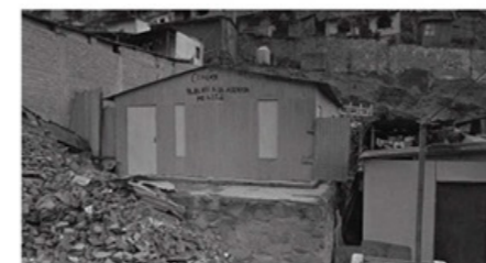
Expuesto a humedad frío y neblina
