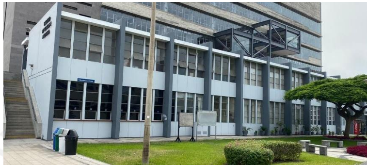
Figura 39: Pabellón A de Ingeniería de la PUCP
