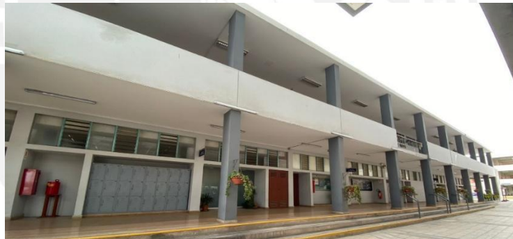
Figura 40: Pabellón A de Ingeniería de la PUCP
