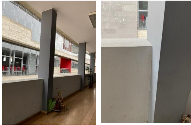
Figura 43: Conexión parapeto-columna
