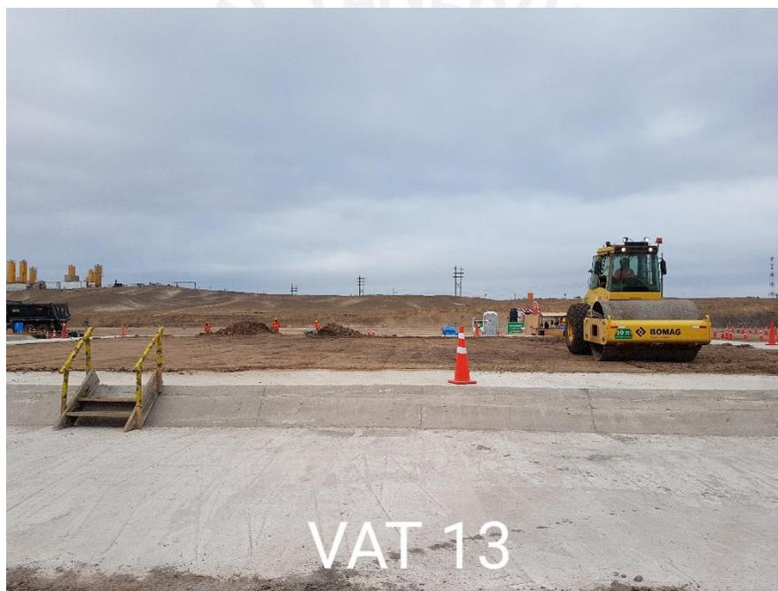
**Figura 4.4.3 Solados y relleno interior**
