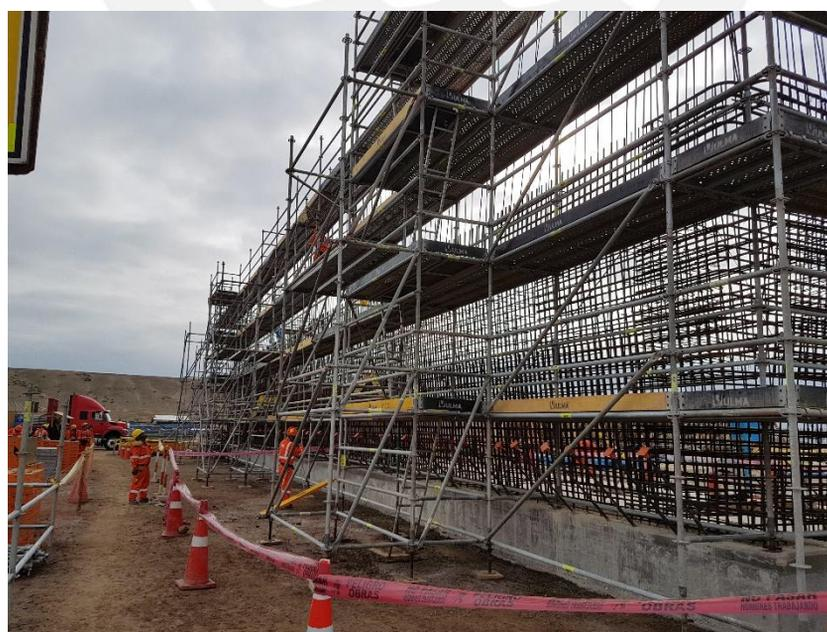
**Figura 4.4.5 Armado de muros**
