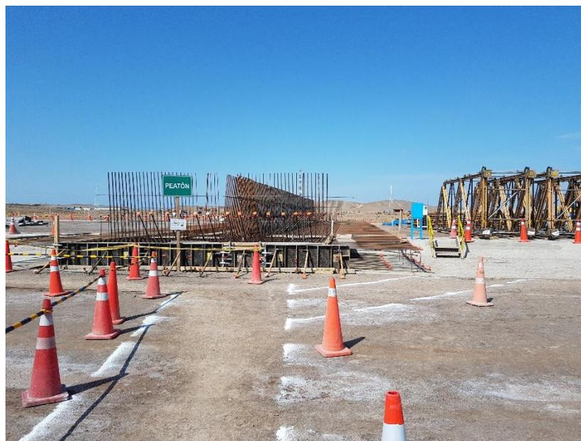
**Figura 4.4.4 Armado de zapatas y arranque de muros**
