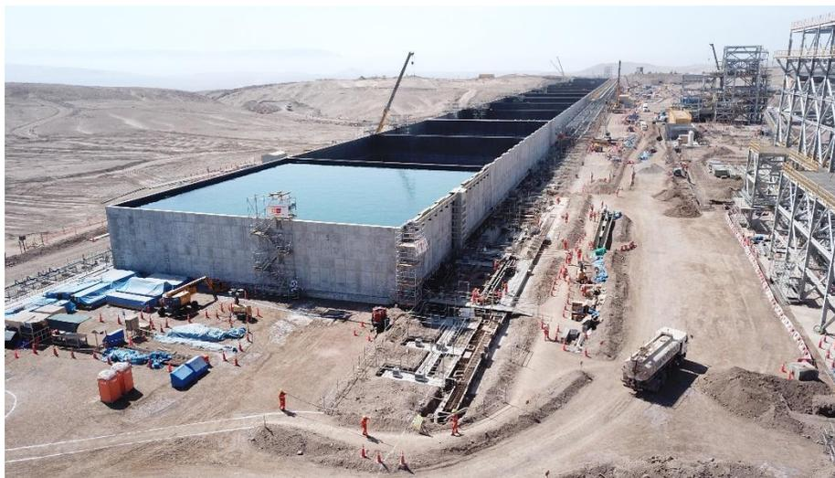
**Figura 4.4.13 Prueba hidrostática Vat #01**
