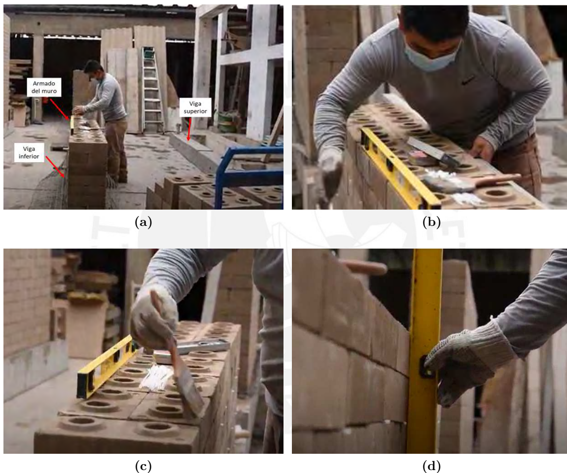
Figura 5.19: Detalles durante el proceso constructivo de los muros sin refuerzo superficial.
