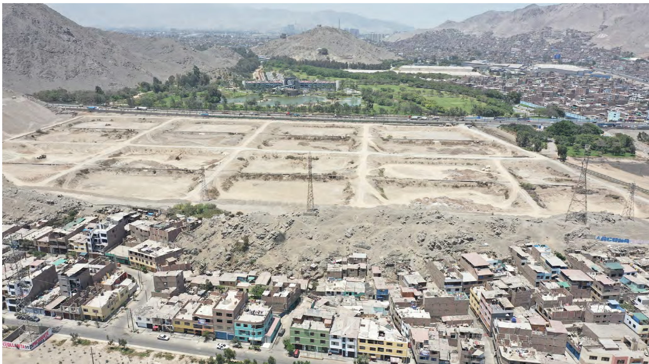
Figura 19. Hermoza, A. (2021). Foto aérea – Reservorios [Fotografía propia].
