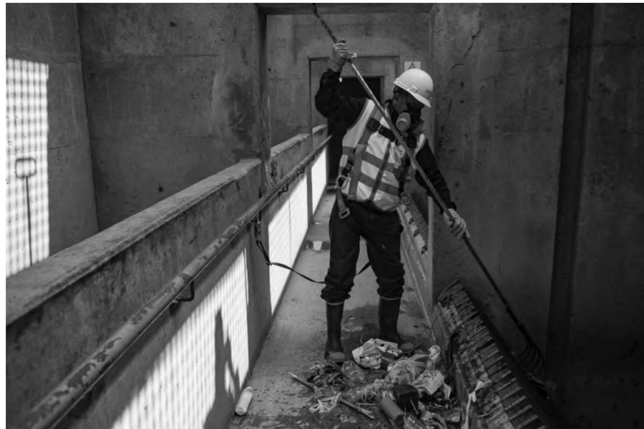
Figura 14. Vargas, V. para Caretas (2010) Limpieza de las rejillas de una de las bocatomas de la Planta de La Atarjea [Fotografía]. Recuperado de: http://sudamerica hoy.com/pais-peru/lima-el-milagro-de-la-ruta-del-agua/
