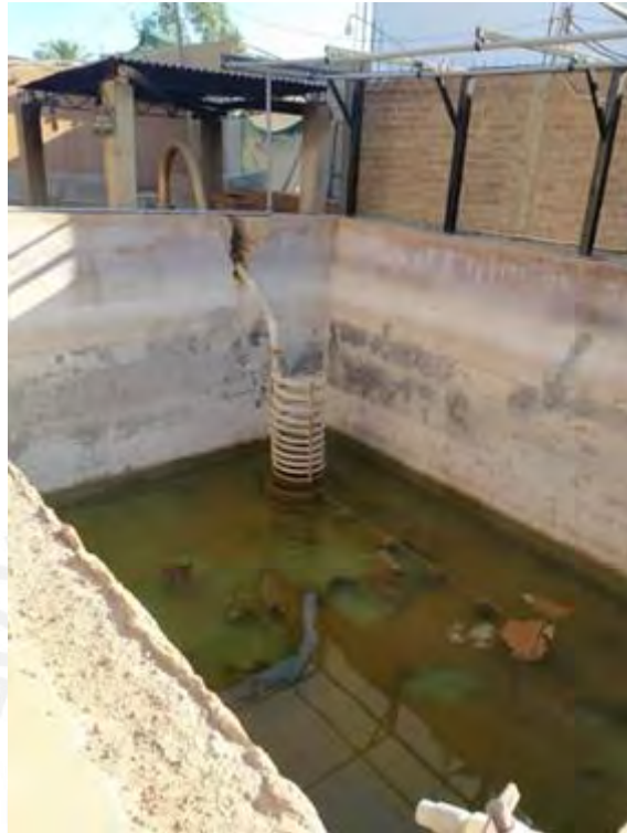
Figura K1: Serpentín y piscina de enfriamiento
