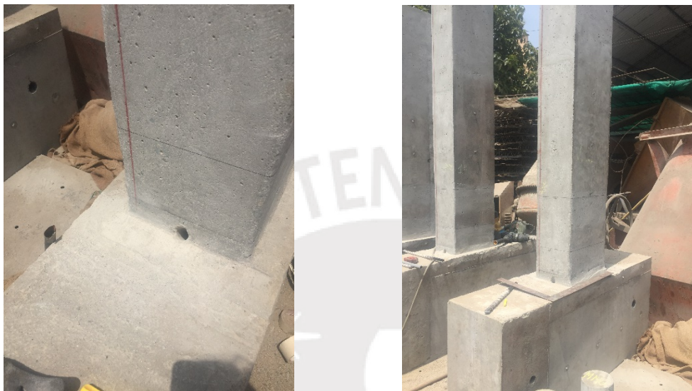
Figura B.1 Perforación en vigas para la colocación de anclajes
