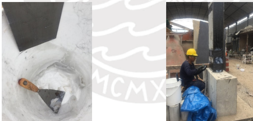
Figura B.4 Preparación y colocación de Resina Carbodur
