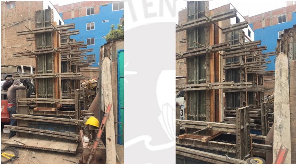
Figura A.3 Encofrado de las cuatro vigas experimentales
