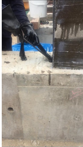
Figura B.5 Colocación de anclajes de FRP
