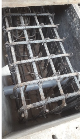
Figura A.2 Vista Superior de la armadura de acero y la separación entre el encofrado y la armadura.
