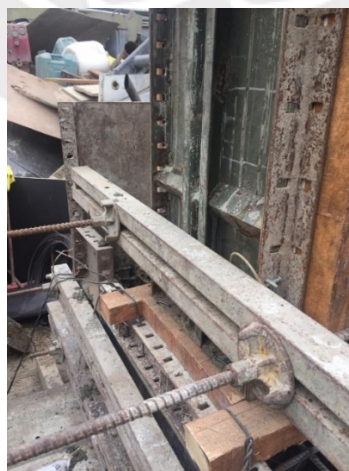
Figura A.4 Detalle del encofrado de vigas
