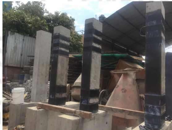
Figura B.6 Cuatro vigas reforzadas con CFRP
