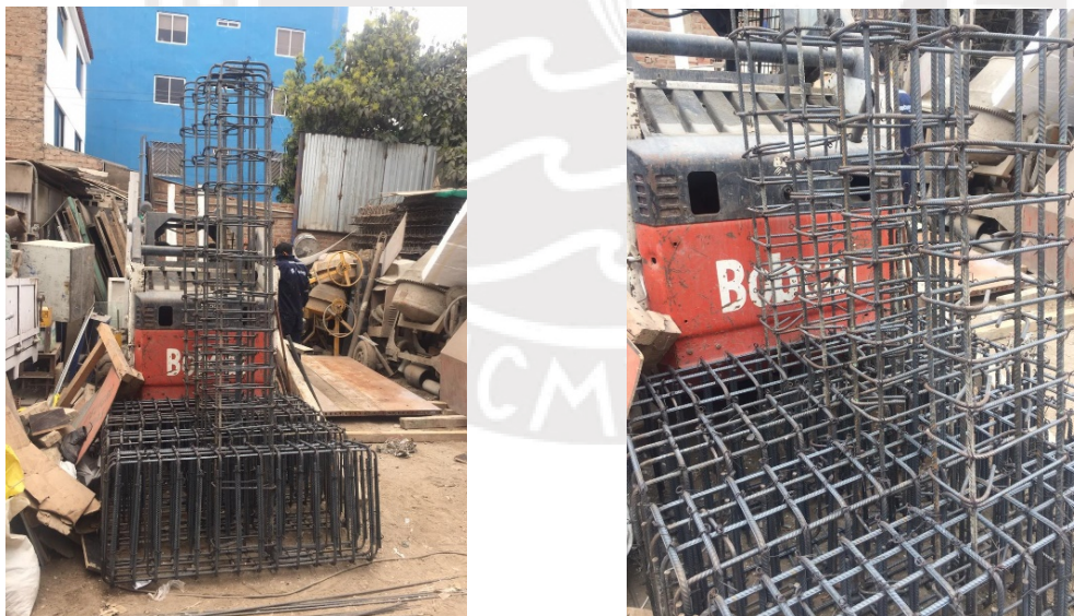
Figura A.1 Armaduras de acero de las cuatro vigas experimentales
