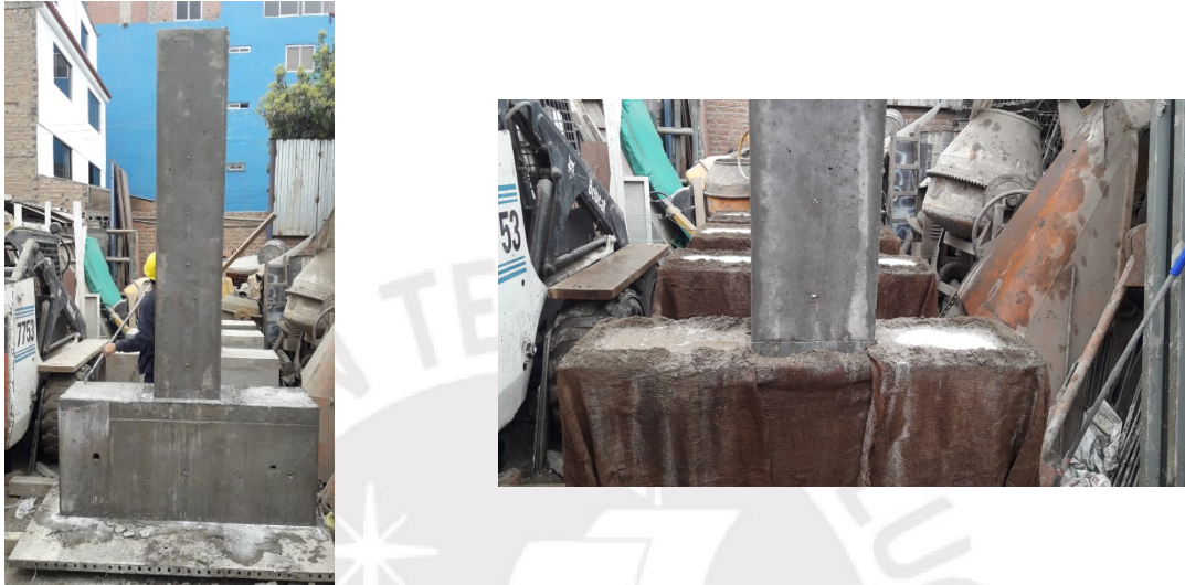
Figura A.5 Colocación de concreto f'c= 210 \text{ kg/cm}^2 y posterior curado.
