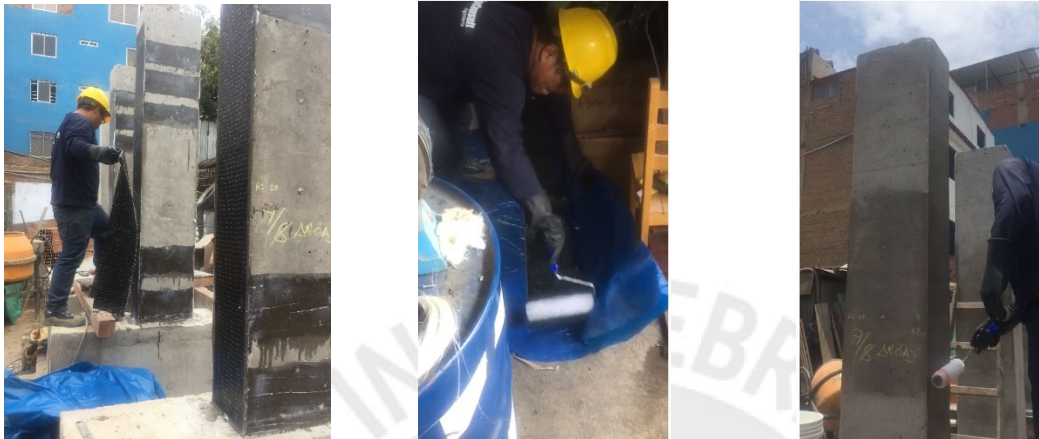
Figura B.3 Colocación del epóxico en las superficies y en la fibra que se instalará
