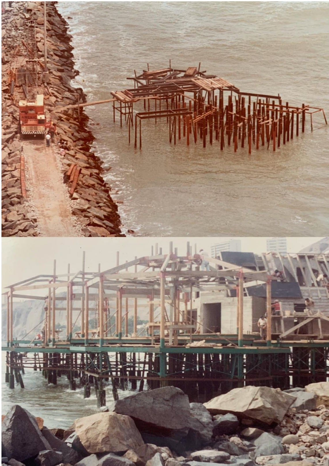
Figura 8 : Procesos en la construcción del edificio. Se muestra la estructura que conecta con el mar y se adosa al espigón de piedras. Además la distribución de los pilotes juntos y arriostrados.
