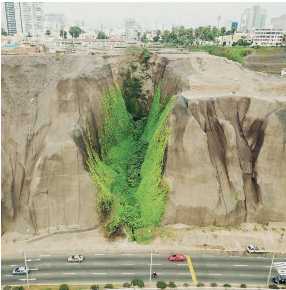
F62. Erosión en la bajada Marbella causada por caída de agua del canal Huaticá
