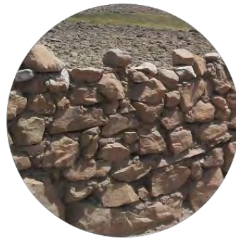
Muro perimetral de piedra
