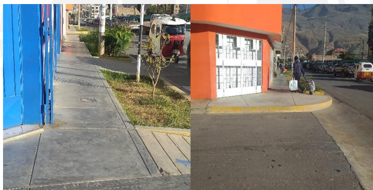
Figura 31. Veredas y rampa en buen estado
