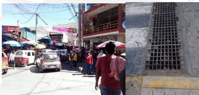
Figura 19. Alcantarillado en las calles de la ciudad
