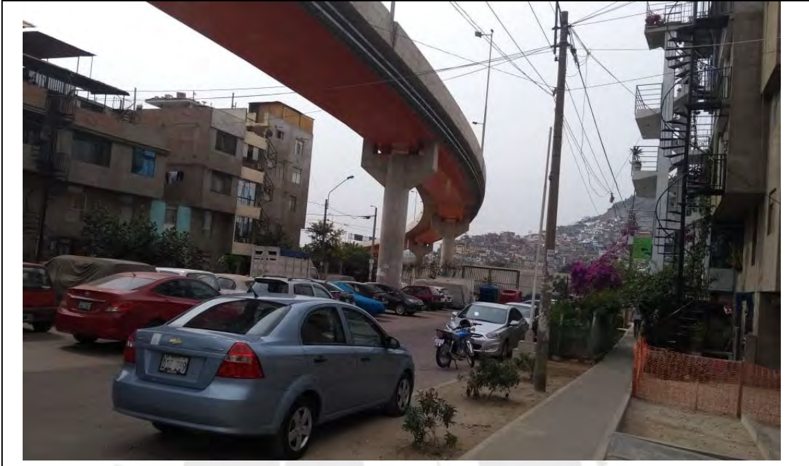
Cruce del viaducto y construcciones adicionales a la vivienda recibida
