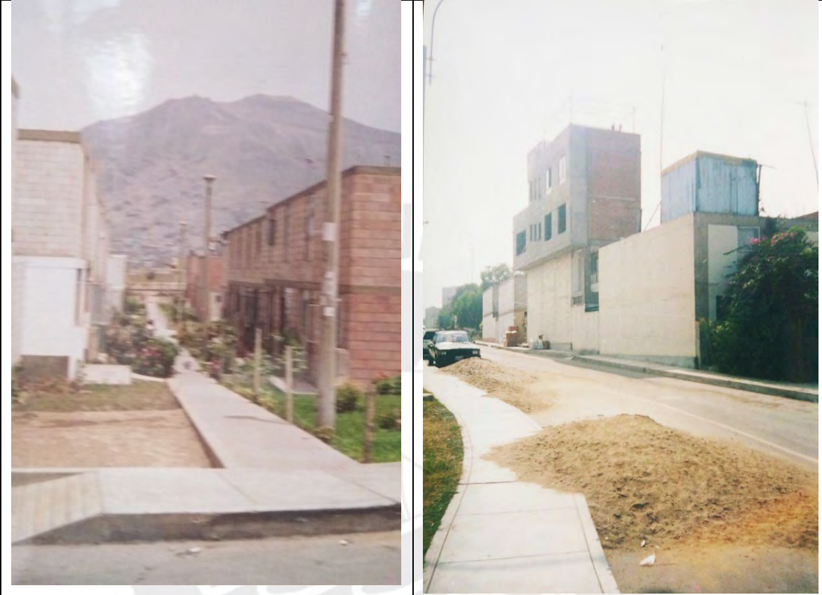
Vista de viviendas construidas.
