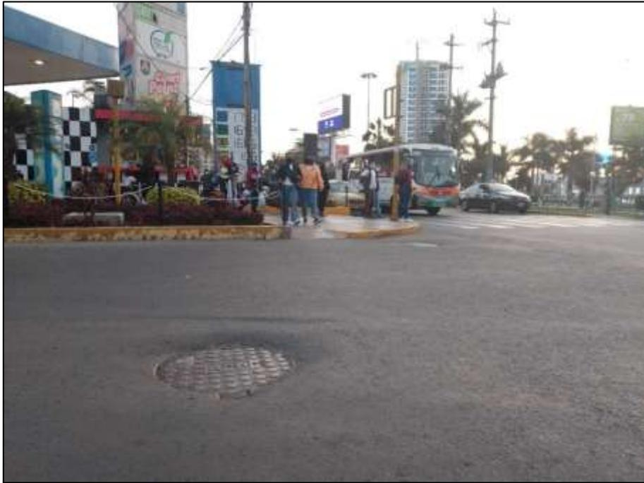
*Figura B.1. Tapas de buzones a desnivel con la calzada*
