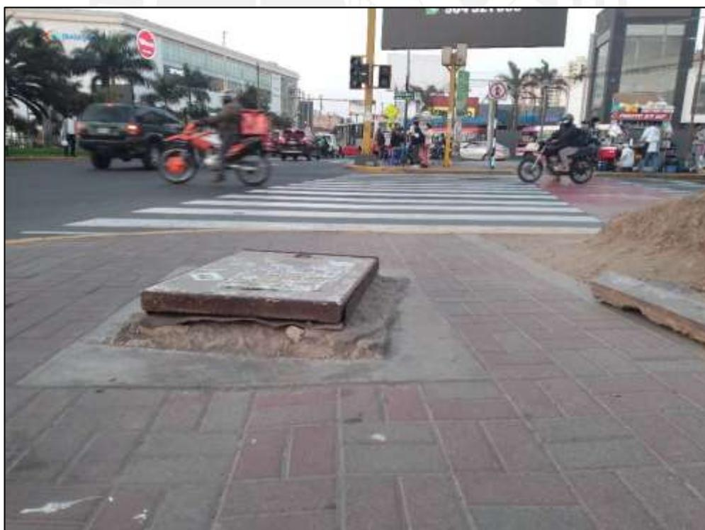
*Figura B.4. Tapas de buzones expuestas y a desnivel de la mediana.*
