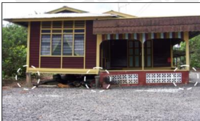
Figura 3.2: Asentamiento a largo plazo de un edificio de bajo peso construido sobre turba de Poncia (Dehghanbanadak et al., 2016).
