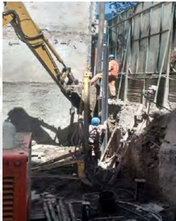
Figura 9. Hincado de perfiles de acero. (Grupo Lac, s/f)
