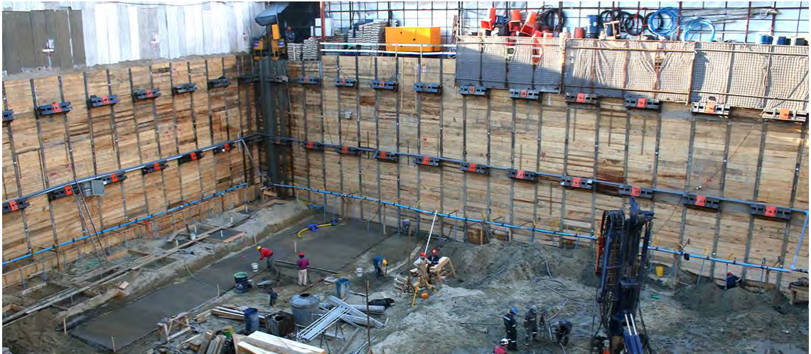
Figura 43. Muro Berlín en el edificio Viana Limache-Chile
