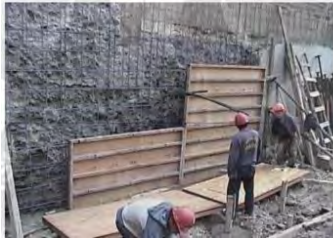
Figura 22. Encofrado de Muro pantalla. (Alvarado, 2019)
