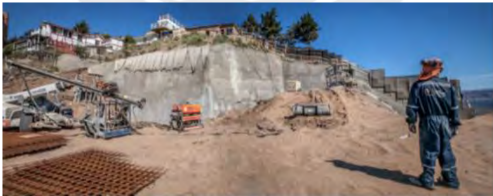
Figura 47. Proyecto de Soil Nailing (Terratest, s/f)
