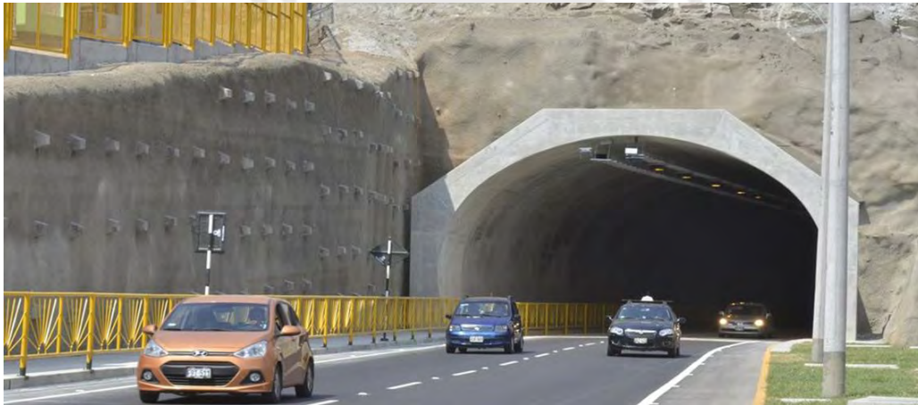
Figura 49. Túnel Santa Rosa Fase II, Perú (Terrajes, s/f)
