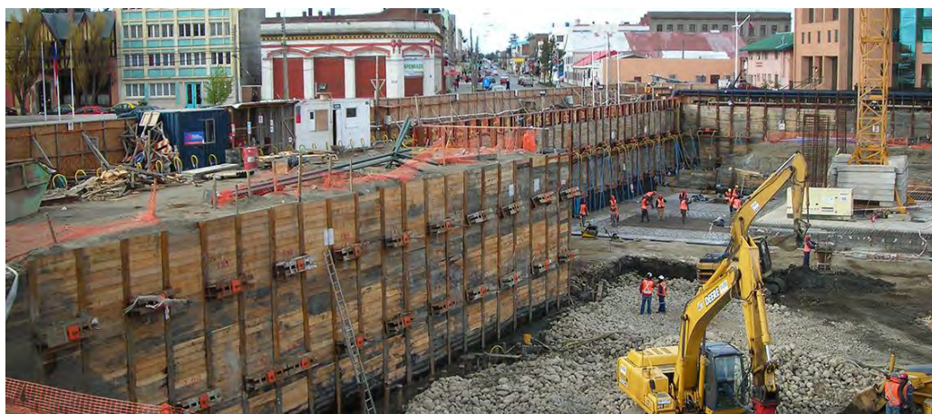
Figura 40. Uso del muro Berlínés en el proyecto Casino Punta Arenas
