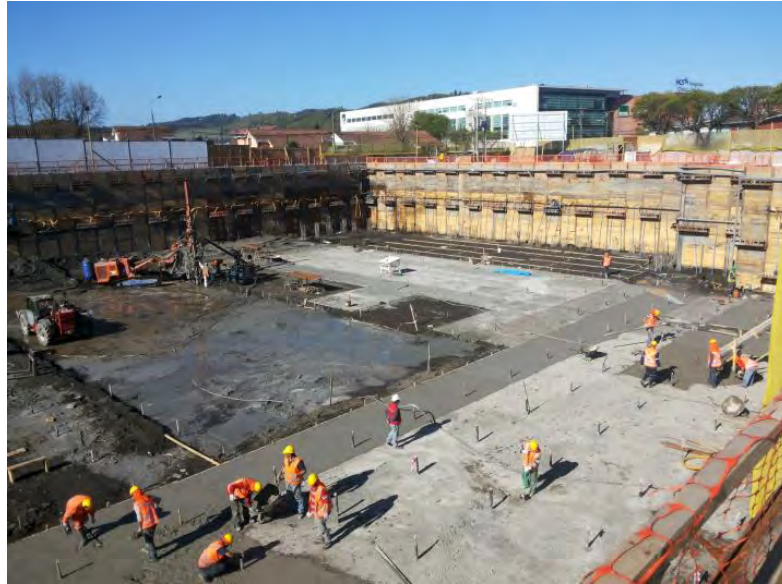
Figura 41. Proyecto: Edificio Las Heras Concepción
