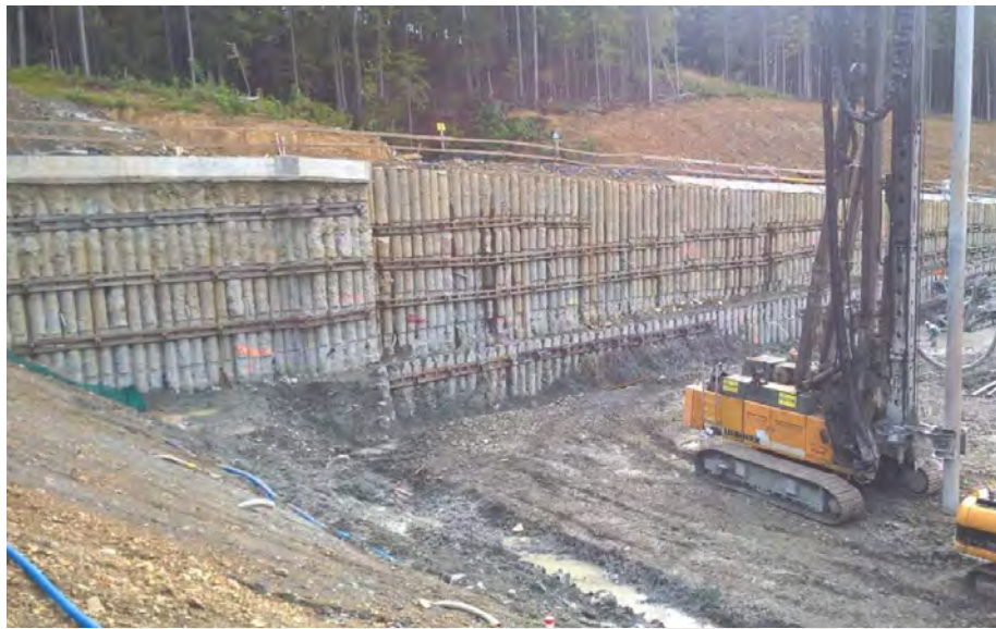
Figura 30. Muros pantalla de pilotes (Fuente: Keller, 2020)
