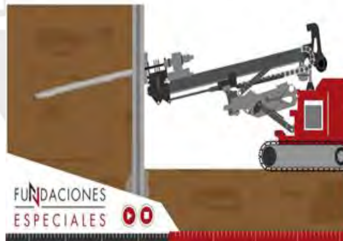
Figura 13. Colocación de anclajes. (Fundaciones especiales, 2019)
