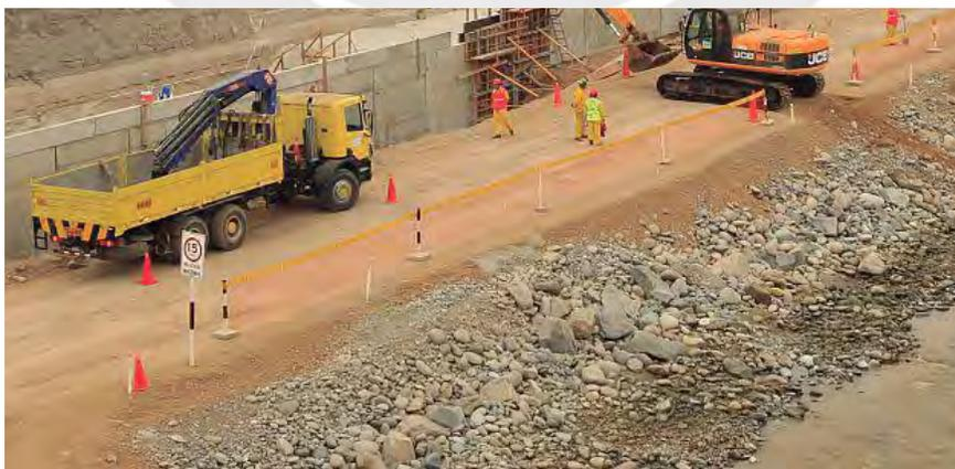
**Figura 4.10:** Uso de señalización de reglamentación. Fuente: CONSTRUVIAL S.A.
