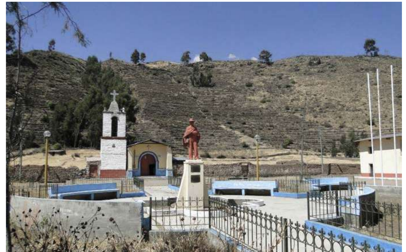
Imagen de un construcción de concreto . Tomado por J.Caniziani (2019)
