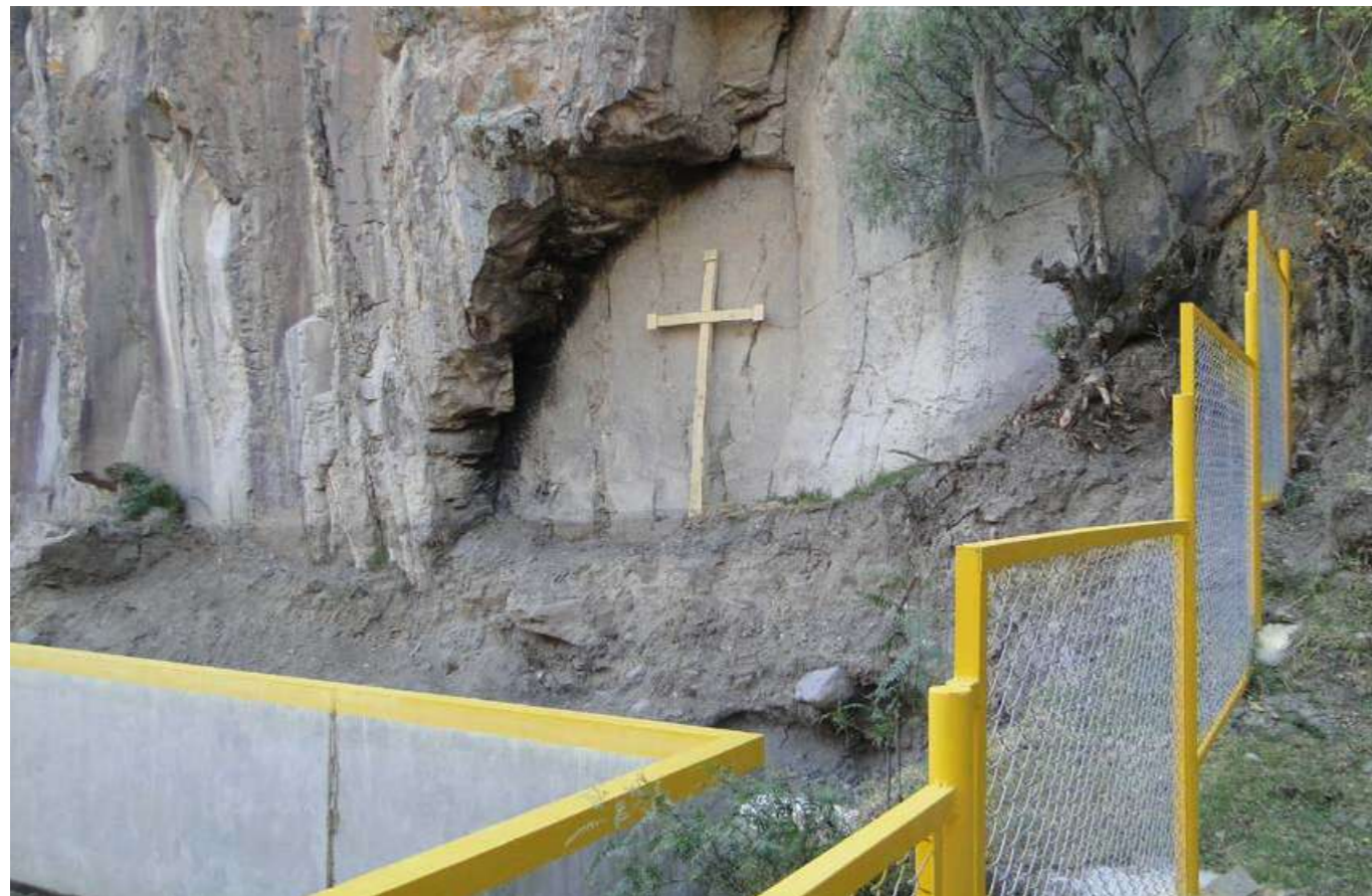
Imagen de un construcción de concreto . Tomado por J.Caniziani (2019)
