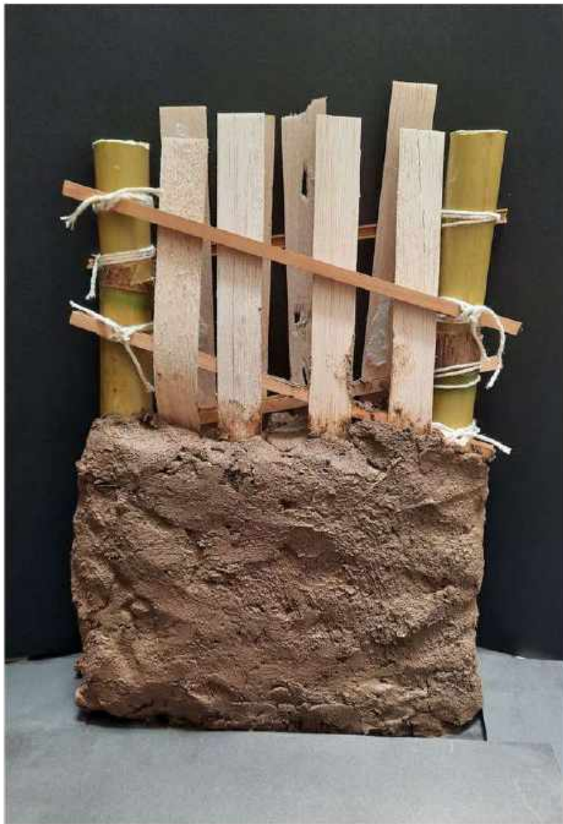
Enquinchado de muros
