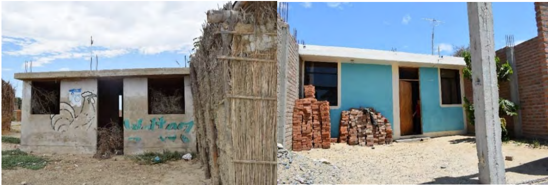
Figura 5. 1. Viviendas en abandono y en reconstrucción
