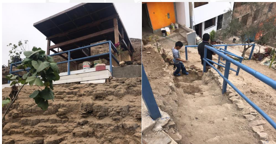
Figura 53. Fotos de las escaleras del área verde en el punto uno (elaboración propia)
