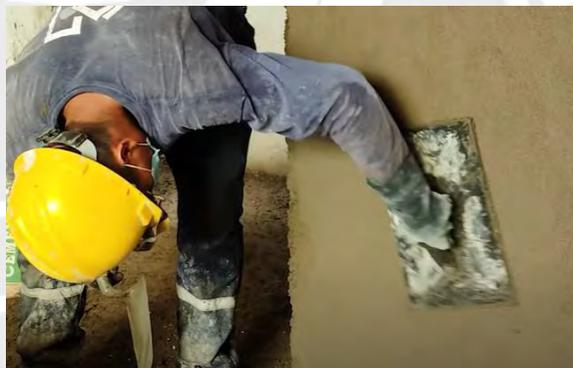
*Figura 6.16 Operario dando el acabado final al tarrajeado (Adaptado de Torrealva,2014)*
