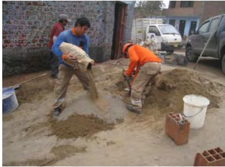
*Figura 6.13 Personal realizando la mezcla de mortero para el pañeteo, esta mezcla se realiza sin agua. (Adaptado de Torrealva,2014).*
