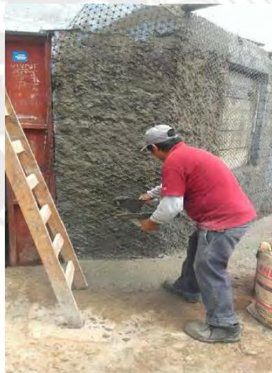
*Figura 6.14 Personal realizando el pañeteo de mortero sobre el muro exterior. (Adaptado de Torrealva,2014).*
