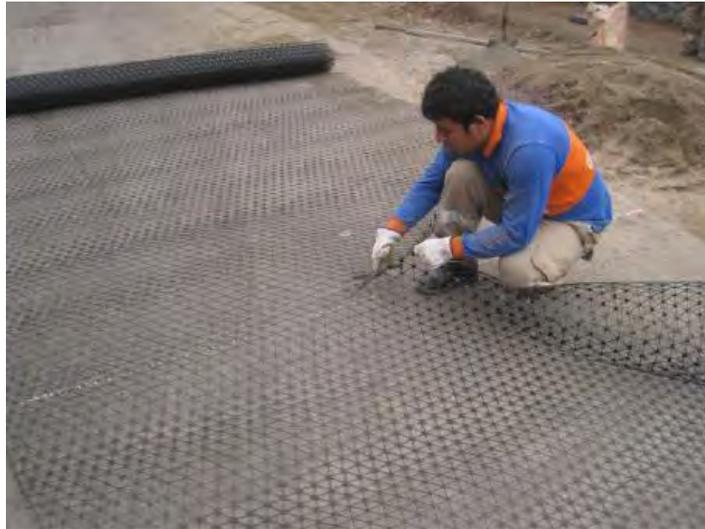
*Figura 6.7 Operario cortando la malla según la medición del muro externo o interno. (Adaptado de Torrealva, 2014).*
