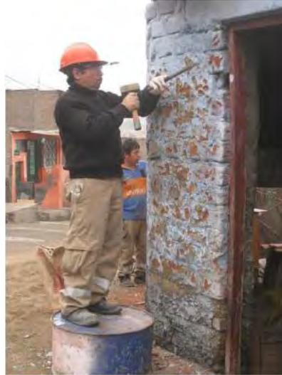
*Figura 6.3 operario picando el muro a reforzar y otro quitando el tarrajeo (Adaptado de Torrealva, 2014)*
