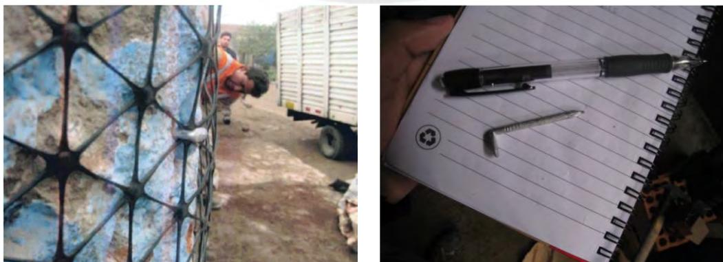
Figura 6.10 Vista cercana de la alcayata y geomalla en el muro (Adaptado de Torrealva, 2014)
