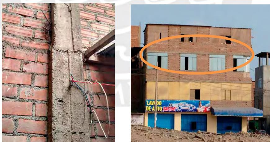
Figura 4.8 Ausencia de vigas de amarre y columnas en muros de albañilería (Swisscontact, 2016).
