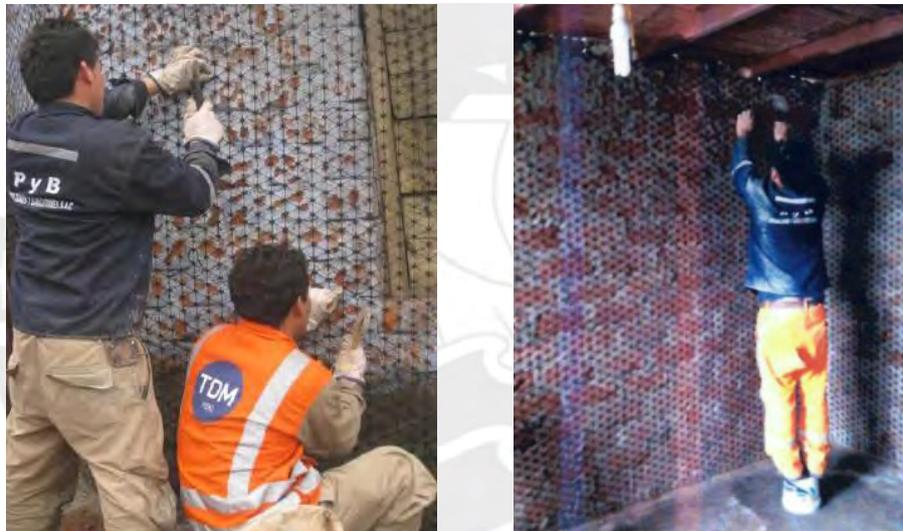
Figura 6.9 Operarios colocando alcayatas cada 50cm para fijar las mallas en el muro. (Adaptado de Torrealva, 2014).
