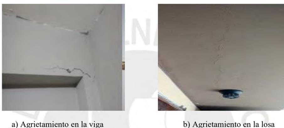
Figura 4.16 Presencia de grietas en elementos estructurales (Swisscontact, 2016).
