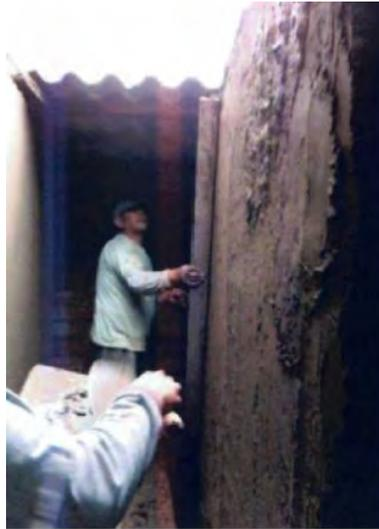
*Figura 6.15 Operario emparejando la mezcla con una regla de aluminio (Adaptado de vivienda piloto en Comas por SENCICO, 2015).*
