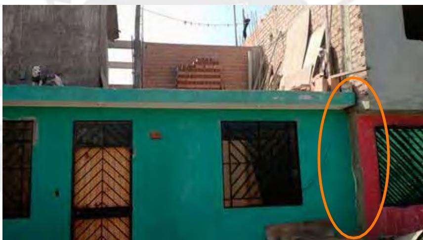
Figura 4.15. Ausencia de junta sísmica en viviendas colindantes (Swisscontact, 2016).
