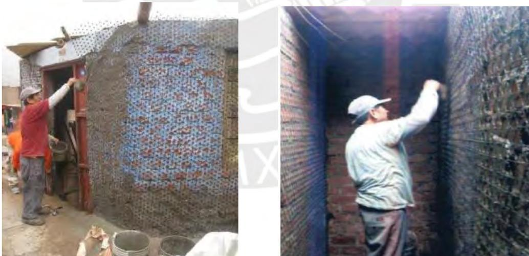
*Figura 6.12 Personal echando lechada sobre el muro exterior e interior. (Adaptado de Torrealva,2014).*
