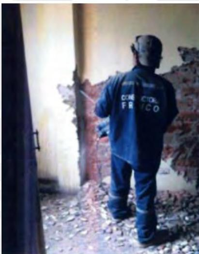
*Figura 6.2 Operario retirando el acabado de la vivienda piloto en Comas
