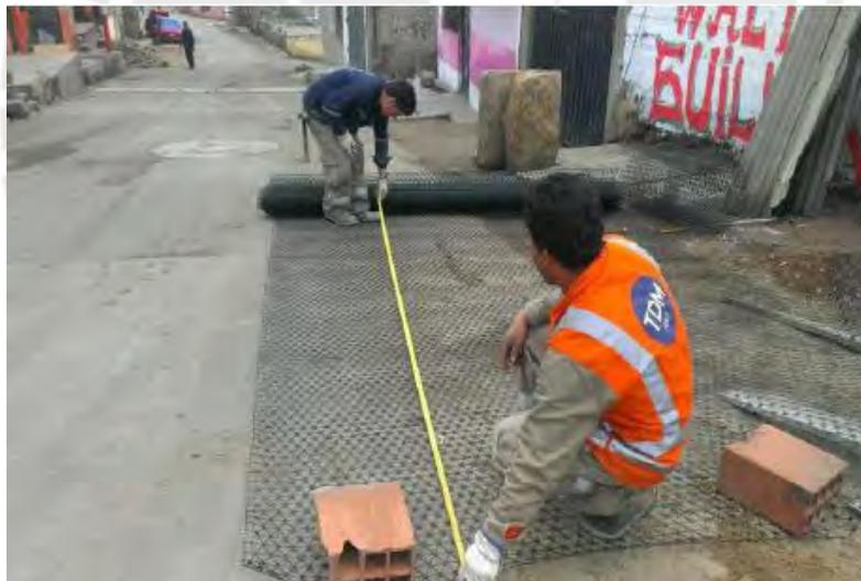
*Figura 6.6 Operario y ayudante realizando mediciones de la malla. (Adaptado de Torrealva,2014).*
