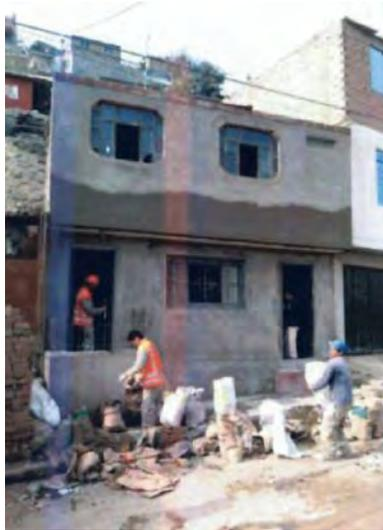
*Figura 6.17 Vivienda piloto en Comas con fachada tarrajeada completamente (Adaptado de vivienda piloto en Comas por SENCICO, 2015).*
