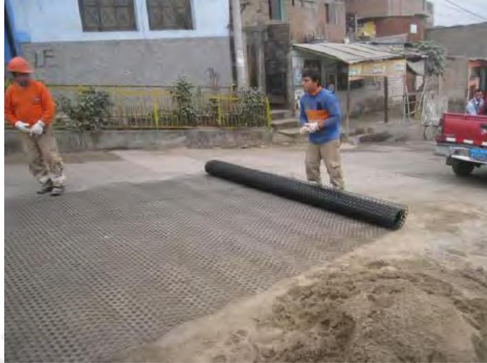
*Figura 6.5 Operario y ayudante preparando la geomalla para medir y cortar. (Adaptado de Torrealva,2014).*
