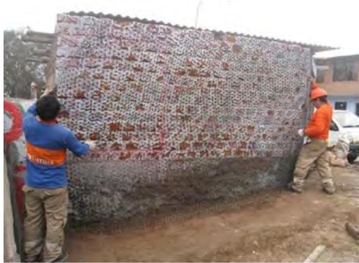
Figura 6.8 Operarios extendiendo la malla a lo largo del muro. (Adaptado de Torrealva, 2014).
