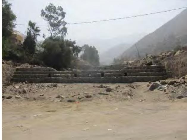
Figura A 11 Presencia de diques erosionados
