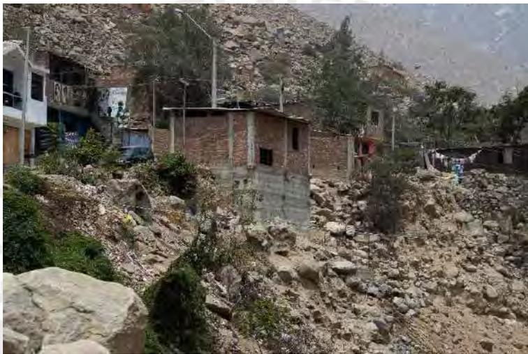
Figura H 8 Base de la casa construida sobre material coluvial
