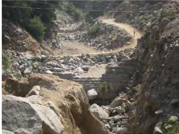
Figura A 3 Presencia de diques erosionados
