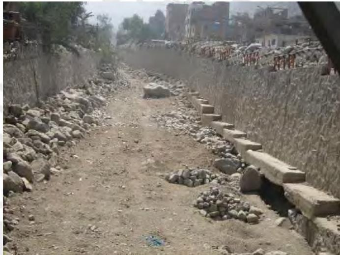
Figura A 7 Vía elaborada para el recorrido del flujo de escombros
