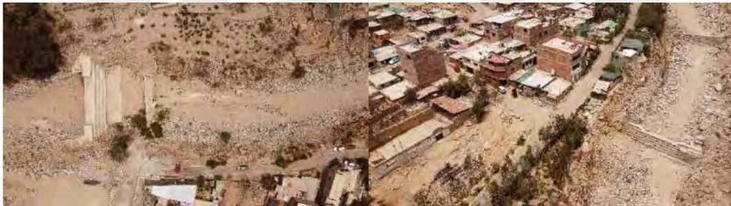
Figura H 15 Presencia de muros disipadores de energía en la zona 7 de la quebrada
