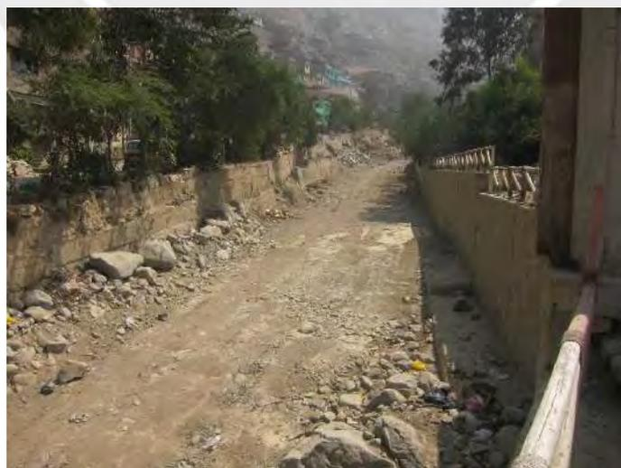
Figura A 8 Vía elaborada para el flujo de escombros en la zona del cono de deyección
