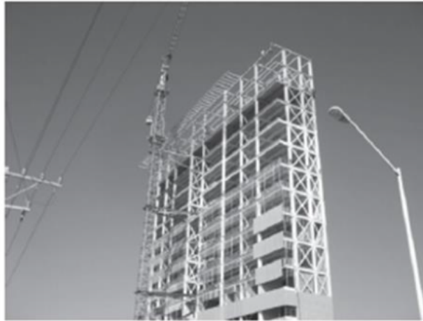
Figura N° 3. Contravento para edificio
