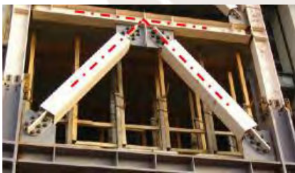
Figura 7. Pórtico con riostra de pandeo restringido.
