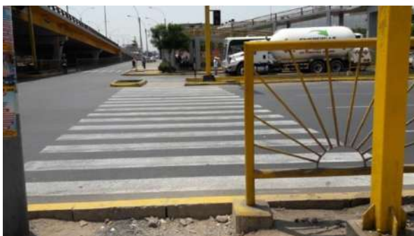
Figura 4.6: Esquinas inaccesibles para acceder al cruceo N°2
