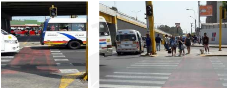
Figuras 4.40 y 4.41: Semáforos peatonales inoperativos
