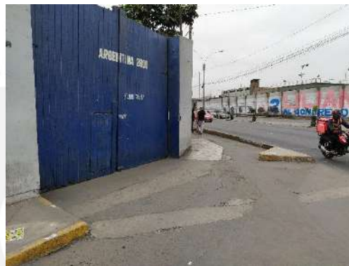
Figura 4.60: La vereda pierde continuidad en la entrada de vehículos
