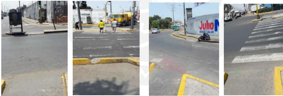
Figuras 4.55, 4.56, 4.57 y 4.58: Falta de rampas en los accesos a los cruces
