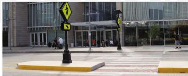
Figura 2.11: Isla de refugio accesible Tomado de “Urban Street Design Guide”, por NACTO (2013)
