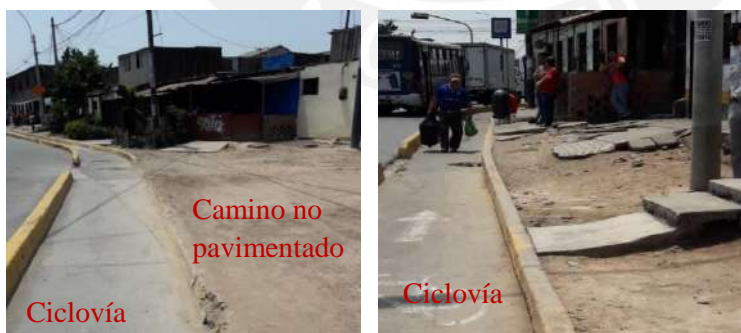
Figuras A2.12 y A2.13: Camino inadecuado para los peatones
