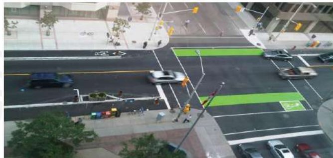
Figura 2.24: Parada adelantada para girar a la izquierda Tomado de “Urban Bikeway Design Guide”, por NACTO (2014)
