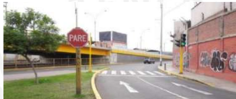
Figura 4.2: Señal de tránsito mal ubicada
