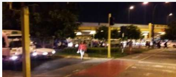
Figura 4.42: Semáforo ubicado antes del cruce peatonal, siendo sus luces indetectables por los peatones esperando a cruzar
