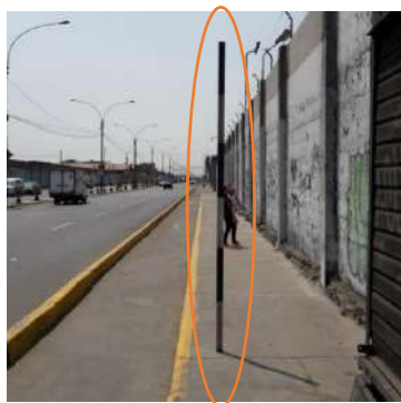
Figura A2.18: Señal incompleta
