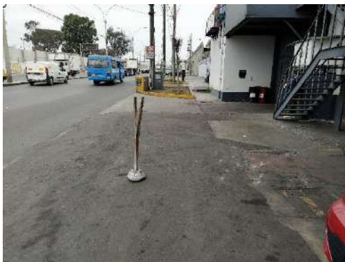
Figura 4.59: Camino peatonal al mismo nivel de la calzada por la presencia de estacionamientos y entradas de vehículos
