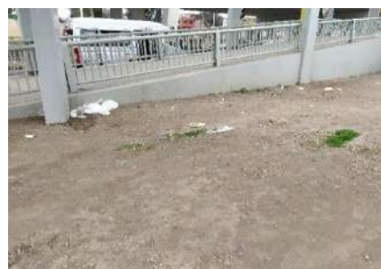
Figura 4.29: Áreas verdes sin mantenimiento en la isla canalizadora derecha
