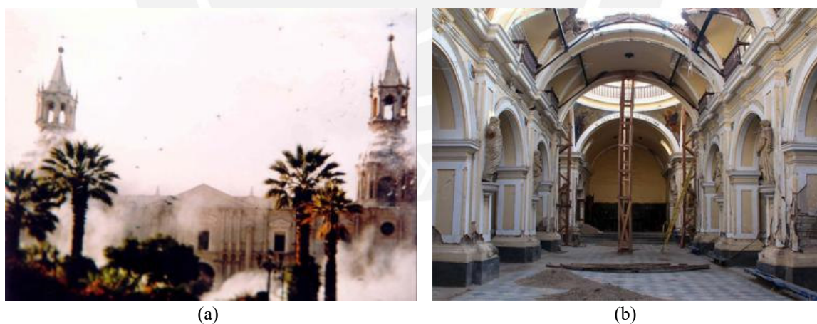
Figura 1.1 Daños ocurridos en iglesias peruanas debido a la ocurrencia de sismos (a) La Catedral de Arequipa en el momento del sismo del 2001 (Torrealva y Blanco, 2002), (b) daños en la nave de la Catedral de Ica (Ciocchi et al., 2017).
