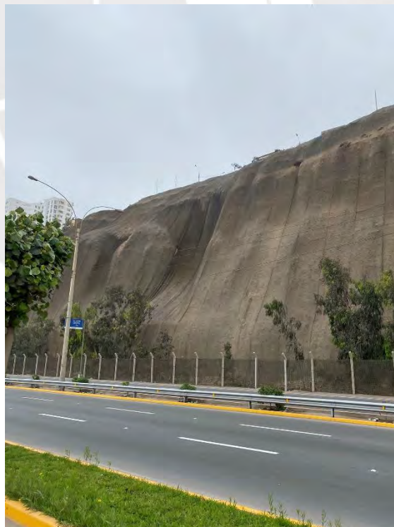
Figura 2.3: Fotografía de un talud del acantilado en el distrito de San Miguel. Fuente propia
