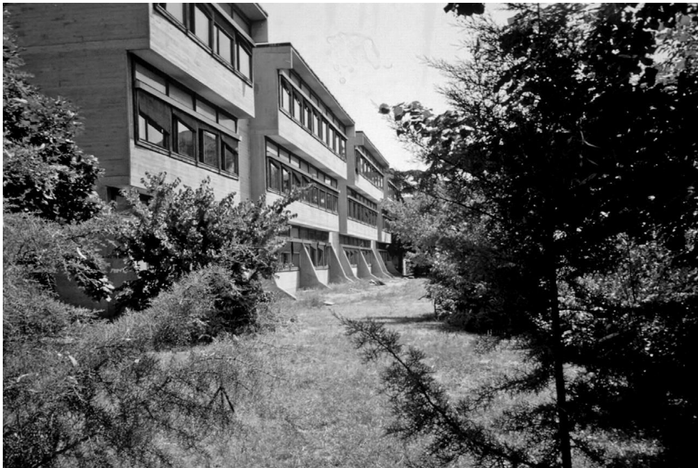
Figura 2.3: El 1er edificio aislado con caucho: La escuela primaria Pestalozzi terminada en 1969 en Skopje. (Kelly, 2011).
