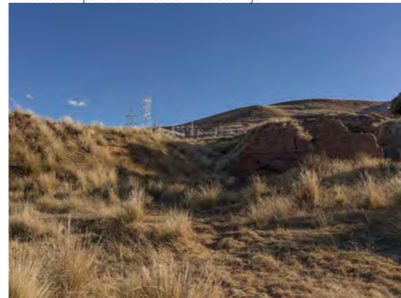
Torres de alta tensión en zonas altas
