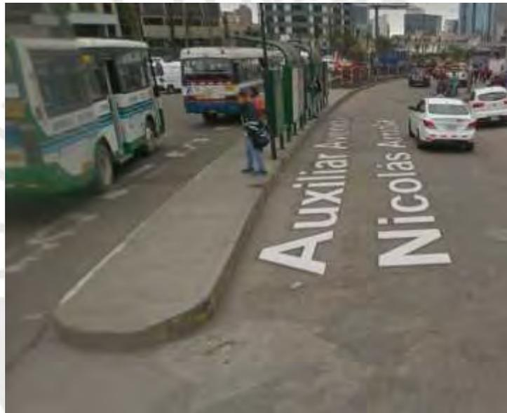
**FIGURA 55: FALTA DE RAMPA PARA ACCESO A PARADERO**
