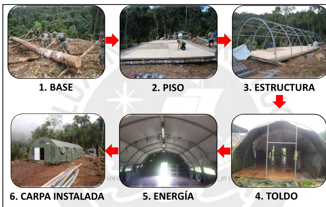
Figura 12. Instalación de carpa modular en campamento temporal para desminadores.
