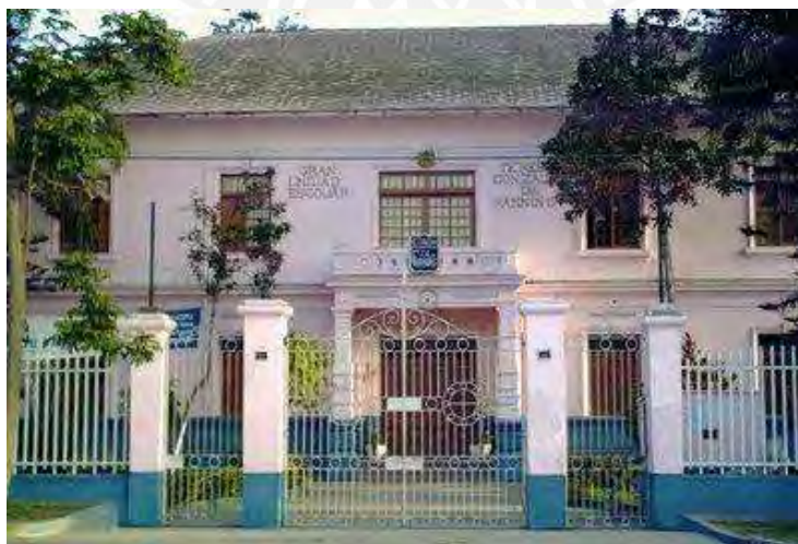
Figura 32. Pabellón de Ingreso a Lima Nikko School (GUE Teresa Gonzales de Fanning). Tomado de Pronied
