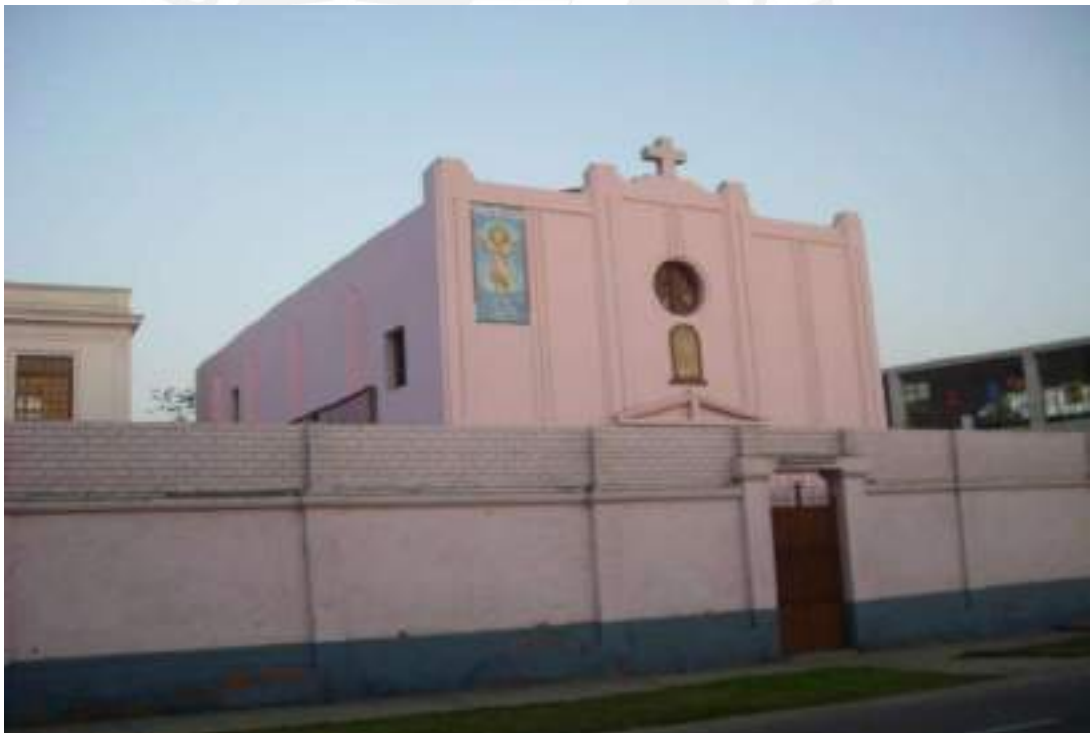
Figura 39. Vista capilla. Tomado de PRONIED
