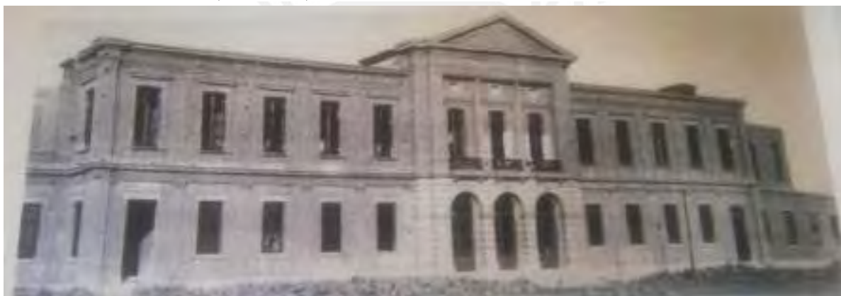
Figura 16. Colegio Guadalupe en construcción (Valdez, 2012).
