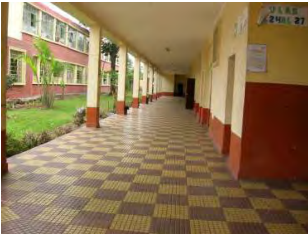
Figura 162. Foto de Pabellón D. Tomado de expediente técnico de Programa de Recuperación de las Instituciones Educativas Públicas Emblemáticas y Centenarias – Proyecto: Juana Alarco de Dammert (Pronied, 2009).
