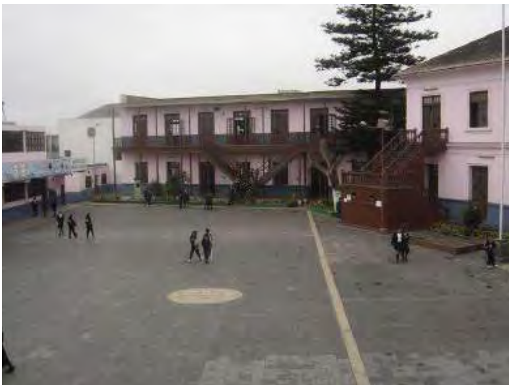
Figura 36. Vista de patio de ingreso de Colegio Lima Nikko. Tomado de PRONIED
