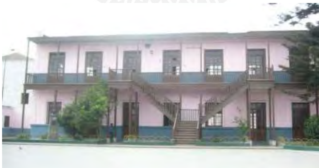
Figura 35. Vista de pabellón de aulas. Tomado de PRONIED
