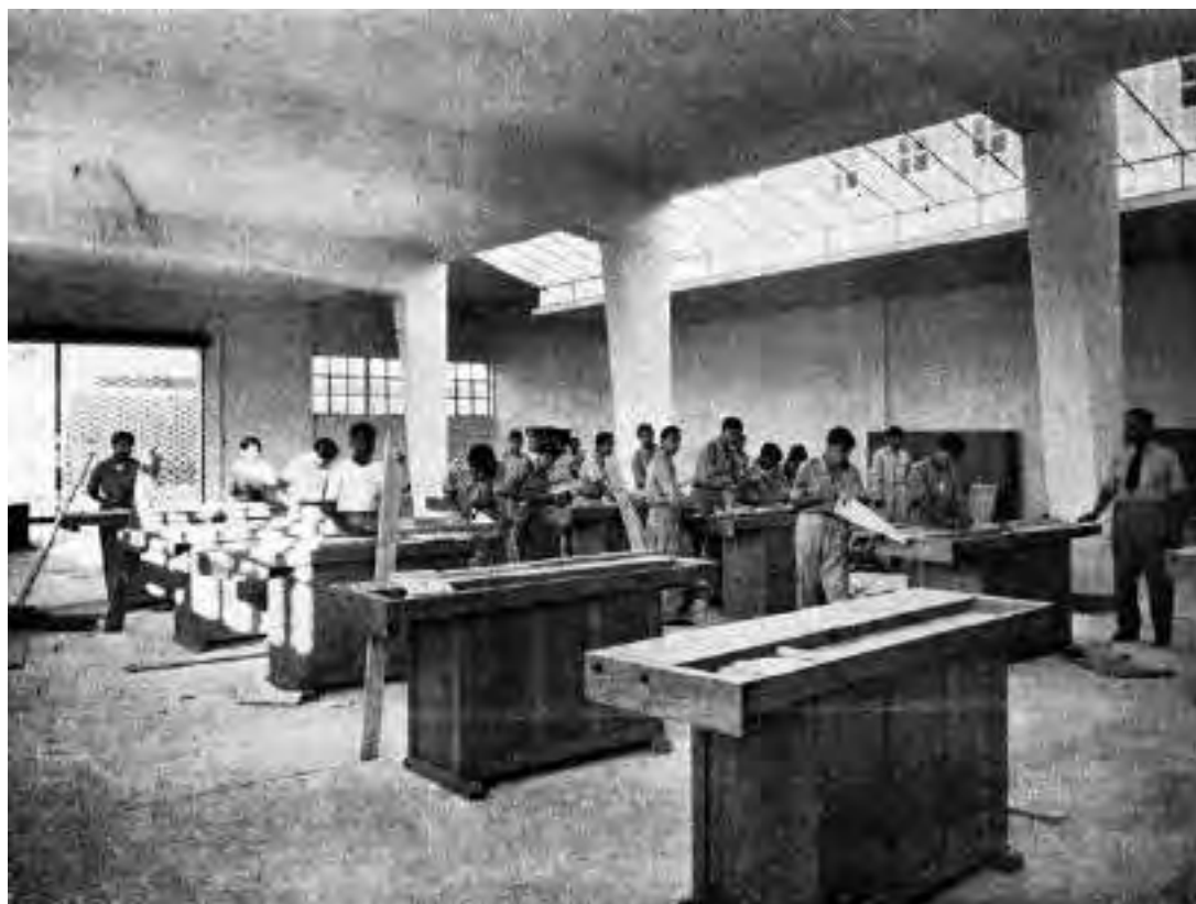
Figura 99. Vista del taller de carpintería (Bravo, 1951:164-165, 13-17)
