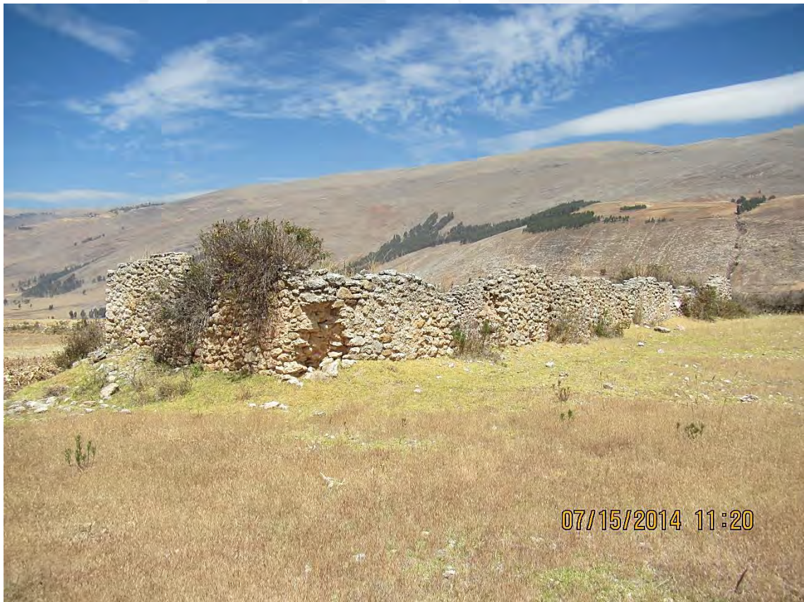
Fig. 86.- Vista del edificio de planta rectangular en el Sector II de Arhuaturo.
