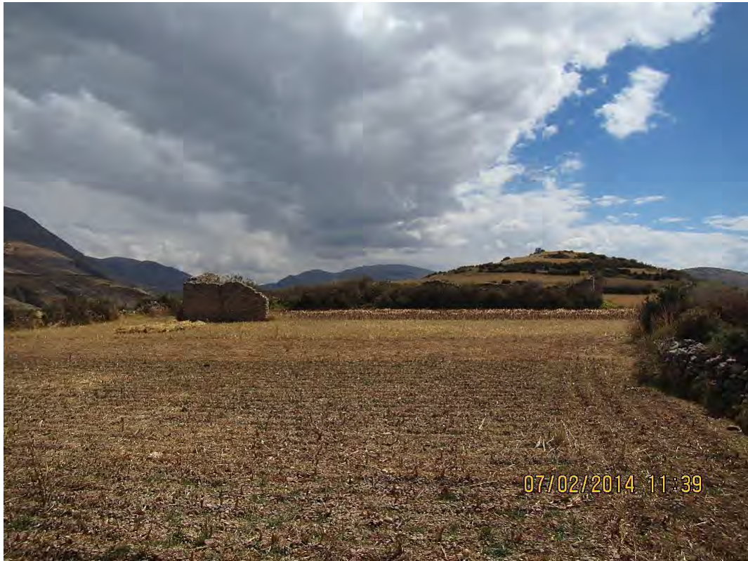
Fig. 85.- Vista de los restos del edificio de planta rectangular en el Sector II de Arhuaturo.
