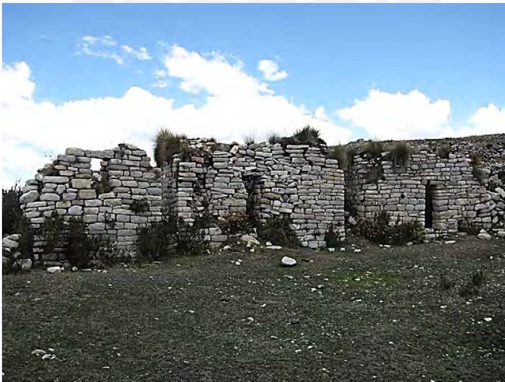
Fig. 154.- Edificios de base rectangular en la zona central de Huajlasmarca (Navarro 2020).
