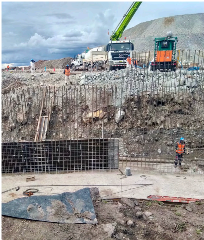
Imagen 9. Infraestructura en Jutumayo
